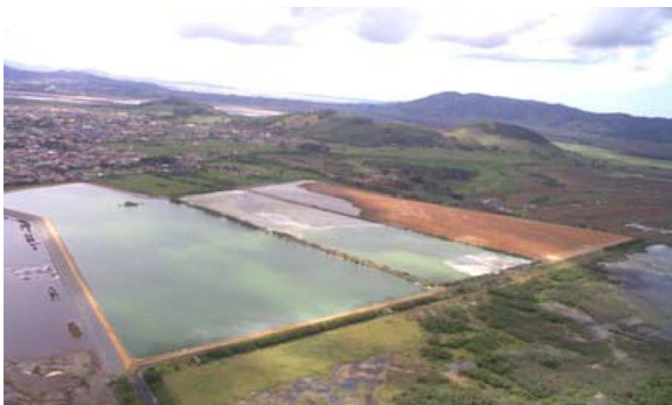
Figura 3: Bacias de sedimentação de cinzas do Complexo Termelétrico Jorge Lacerda. Fonte: CAMARA, 2011
