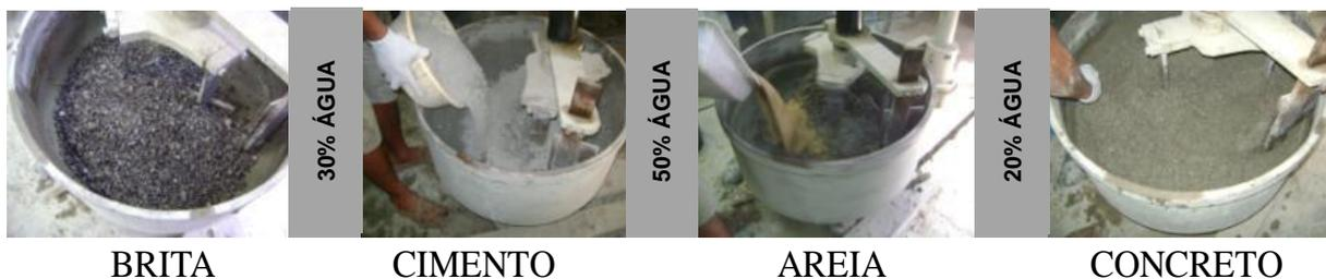
Figura 35: Ordem tradicional de colocação dos materiais constituintes do concreto convencional com AGRC<sub>30</sub> (Ordem A)
