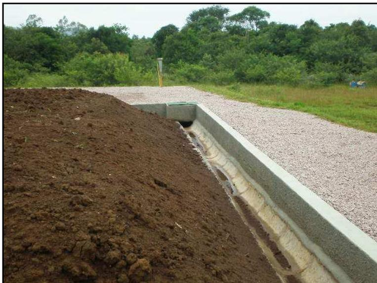
Figura 10 – Calhas utilizadas para captação do escoamento superficial.
