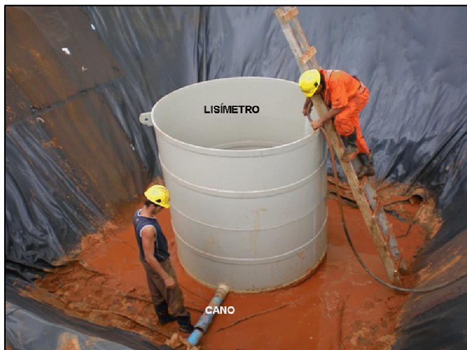
Figura 8 – Célula mostrando o revestimento com geomanta, a instalação do lisímetro e o cano de drenagem.
