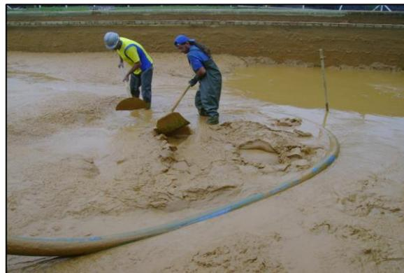
Figura 4. Lodo gerado a partir do tratamento ativo da DAM. Fonte: Silva, (2009).
