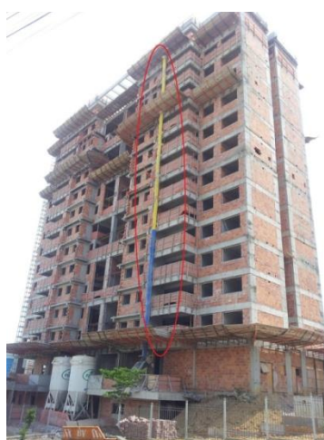
Figura 16 – Transporte por condutor de entulho
