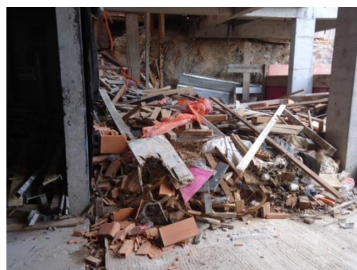
Figura 15 – Aglomerado de resíduos para descarte dispostos de forma irregular
