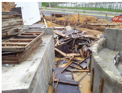
Figura 20 – Madeira para reutilização disposta de forma irregular
