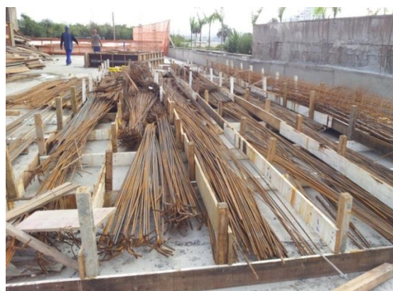
Figura 7 – Exemplo da forma de disposição de aço em canteiro de obra
