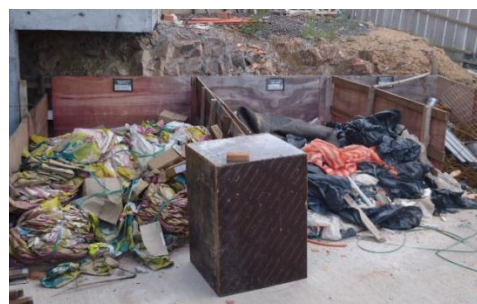
Figura 13 – Baias de armazenamento de resíduos
