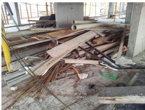
Figura 19 – Madeira para reutilização disposta de forma irregular e com resíduos misturados
