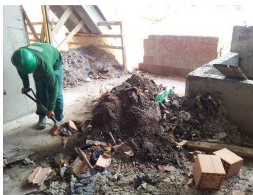
Figura 11 – Servente limpando local de trabalho
