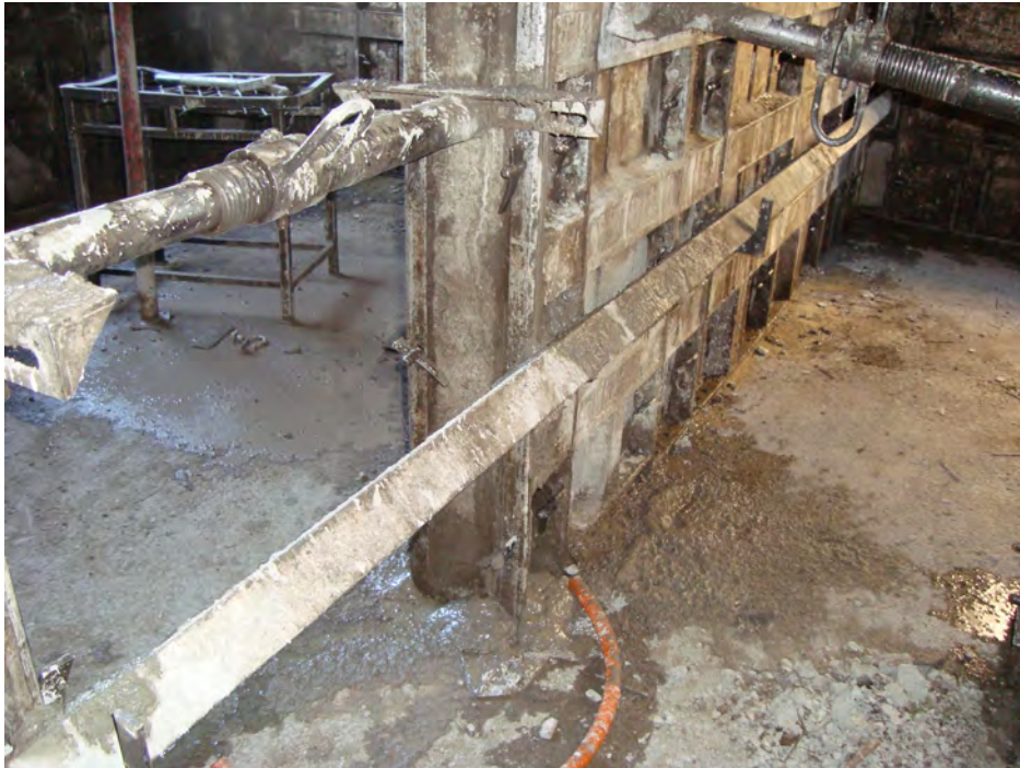
Figura 23 – Macacos entre os vãos das portas e alinhador ao lado das fôrmas
