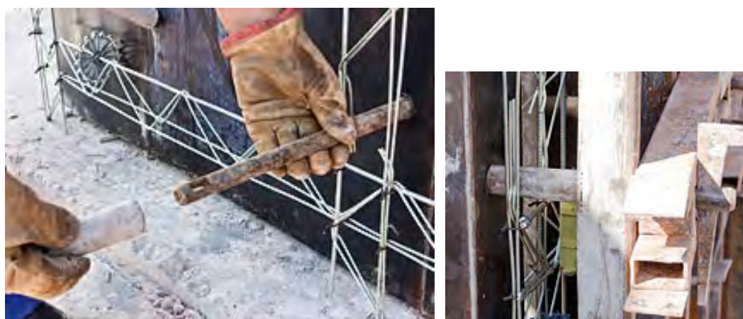
Figura 11 – Colocação e encaixe dos pinos com bucha
