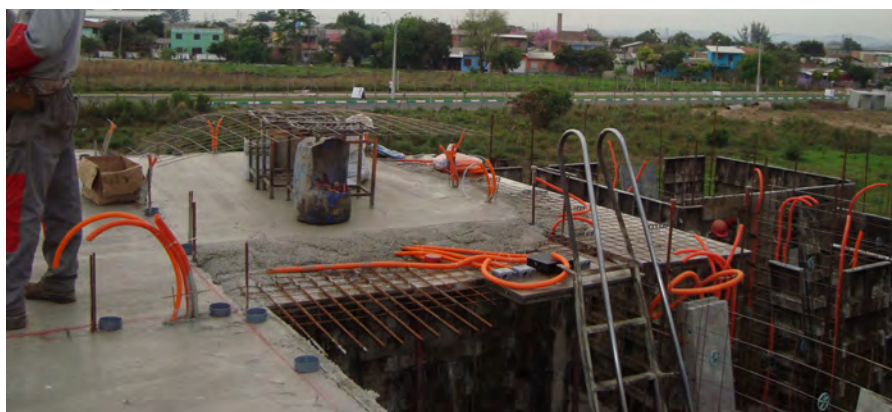
Figura 41 – Junta de concretagem
