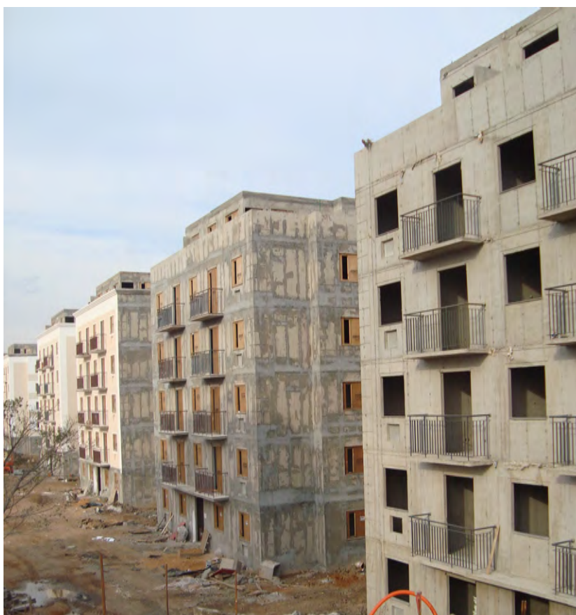
Figura 22 – Obra em andamento
