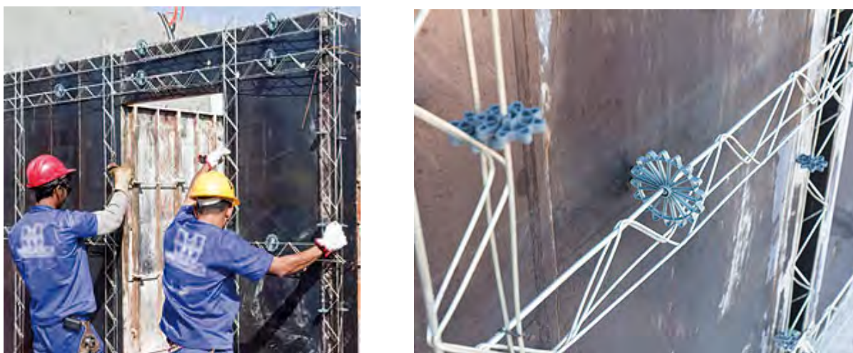
Figura 8 – Colocação das armaduras e espaçadores
