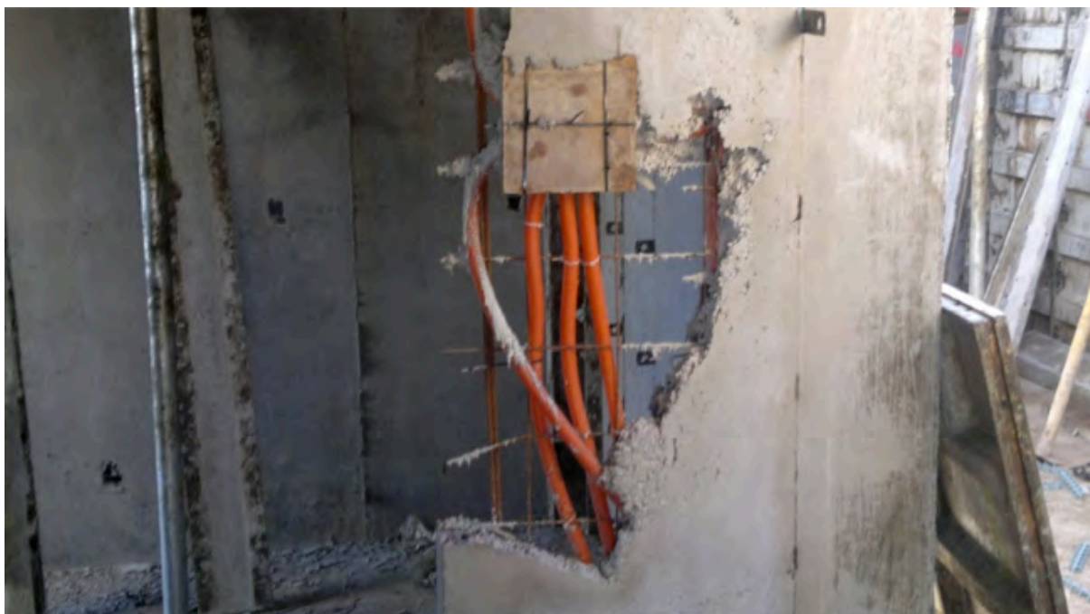
Figura 5 – Ninhos de concretagem
