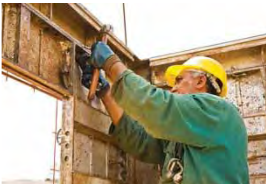
Figura 7 – Montagem das fôrmas
