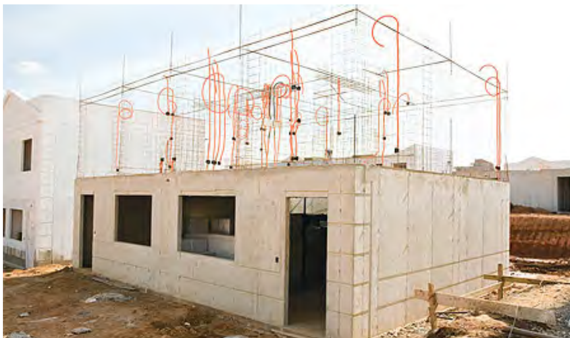
Figura 2 – Execução das paredes de concreto moldadas no local
