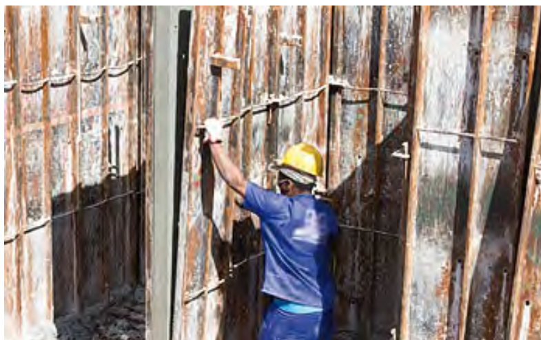
Figura 16 – Desforma
