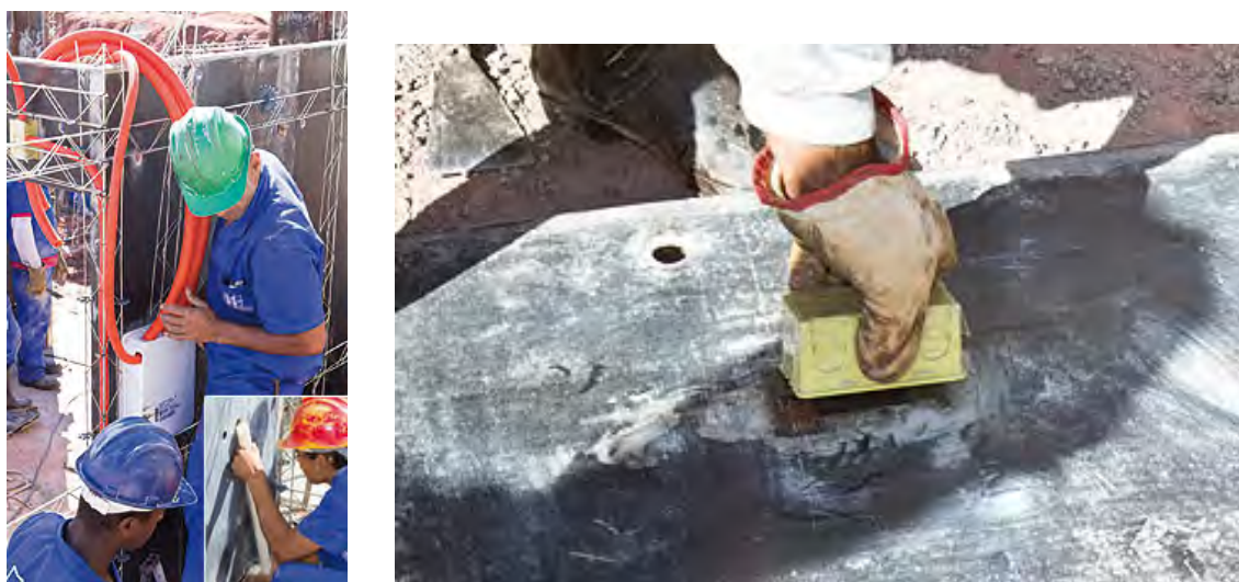
Figura 9 – Colocação das tubulações e caixas elétricas
