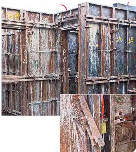
Figura 12 – Colocação das régulas alinhadoras
