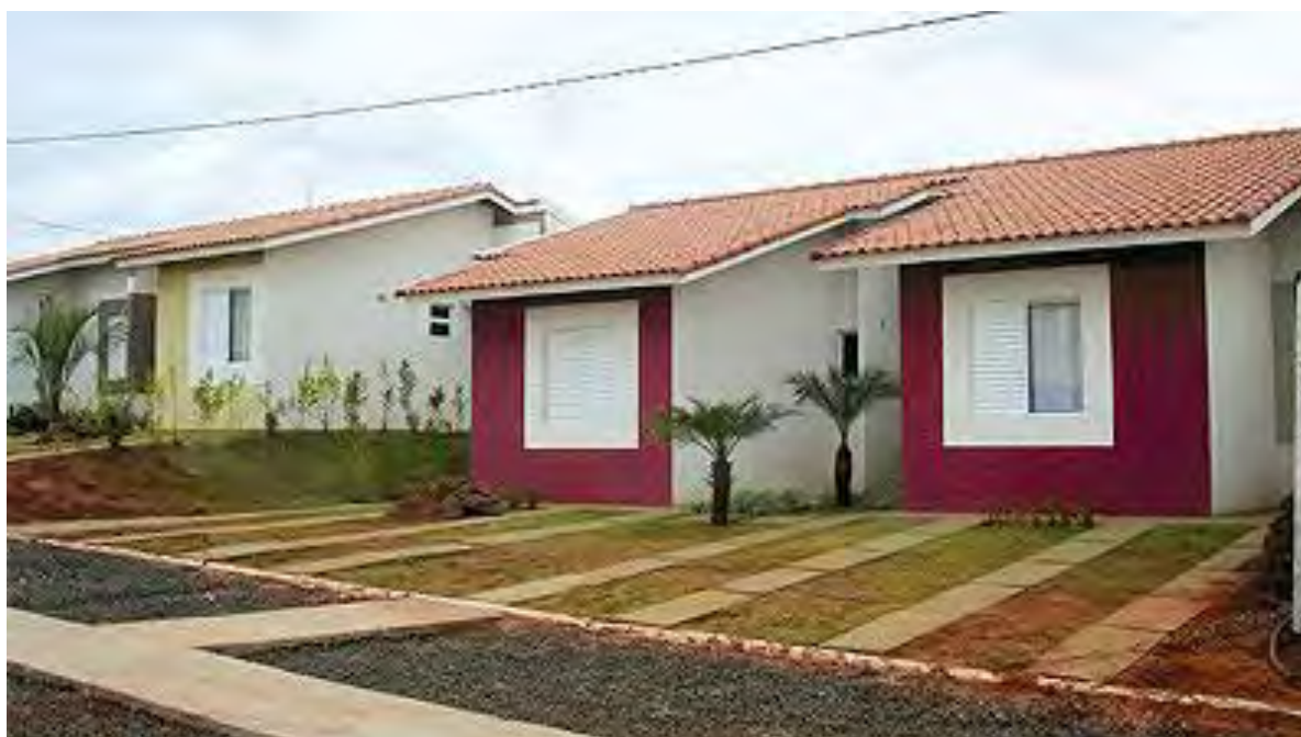
Figura 3 – Casas térreas construídas com sistema de paredes de concreto
