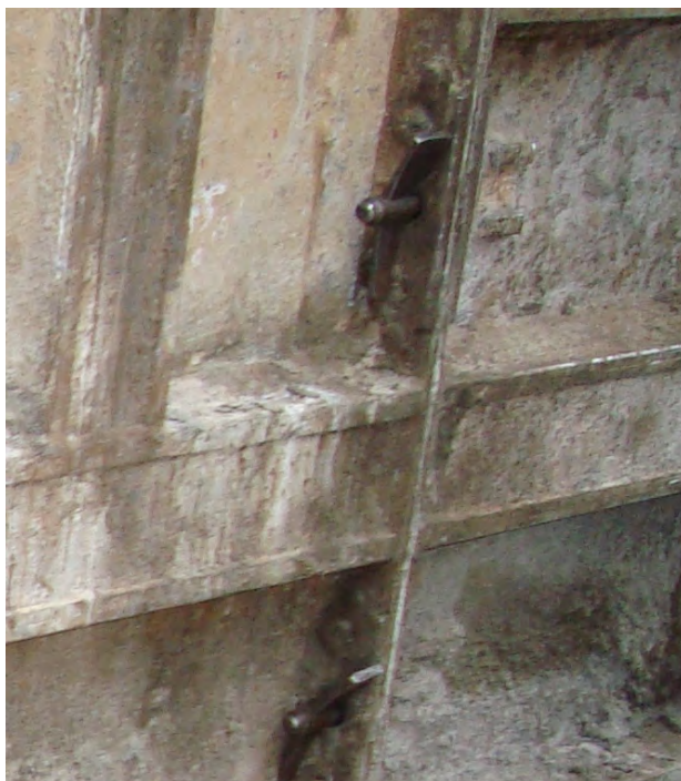
Figura 25 – Pinos e cunhas para fechamento e travamento das fôrmas
