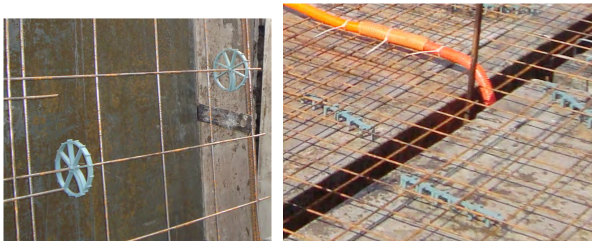
Figura 31 – Espaçadores bolacha e lagartixa
