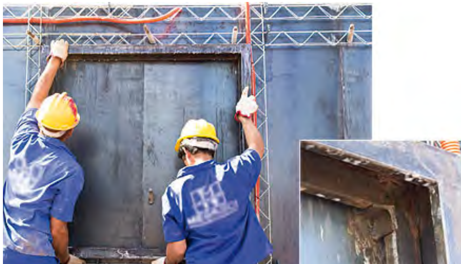
Figura 10 – Colocação dos gabaritos
