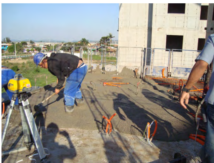
Figura 37 – Nivelamento da laje
