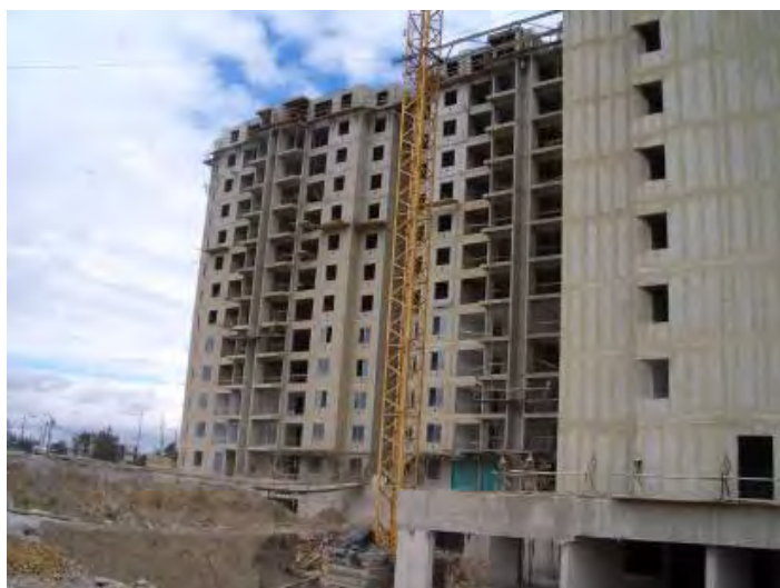
Figura 4 – Edifício residencial Bogotá na Colômbia
