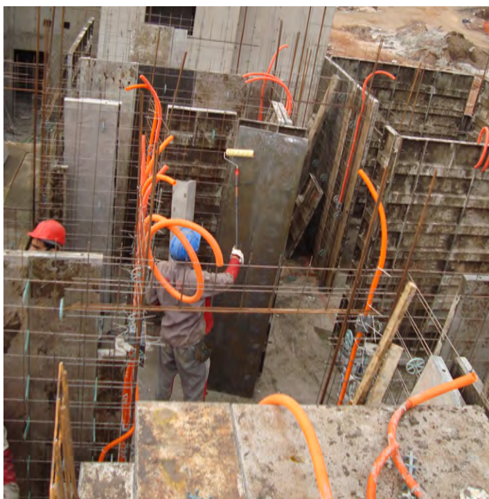
Figura 29 – Aplicação de desmoldante
