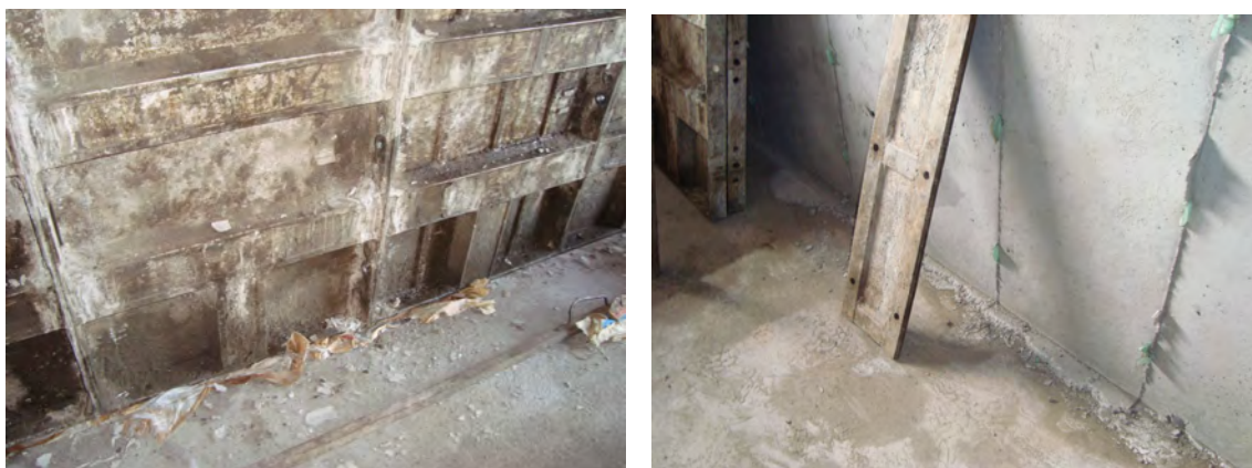
Figura 34 – Tentativa de fechamento das juntas e perda de pasta
