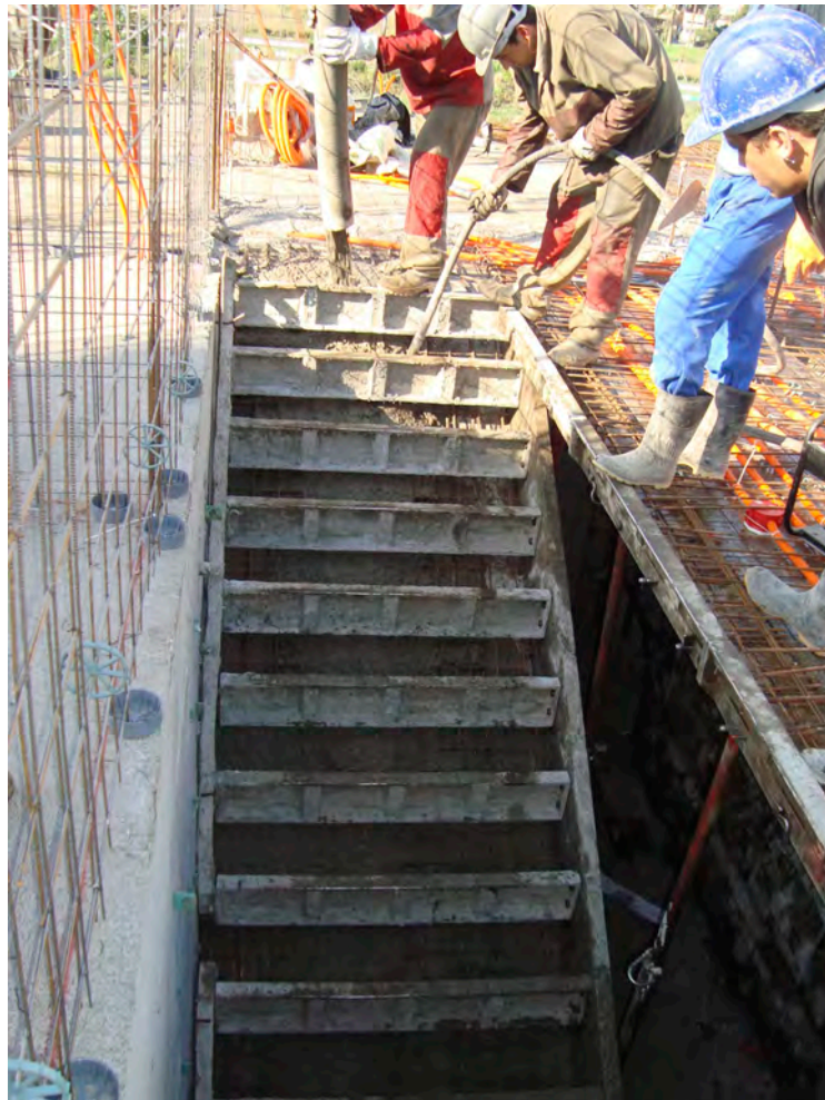
Figura 39 – Concretagem das escadas
