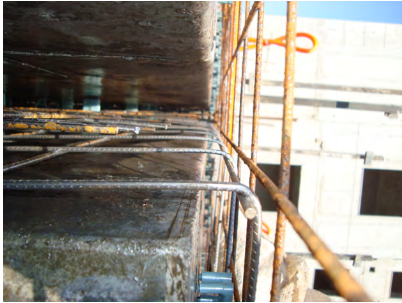
Figura 33 – Ancoragem entre lajes e paredes
