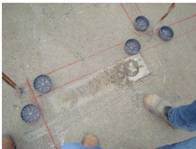
Figura 35 – Marcação das paredes
