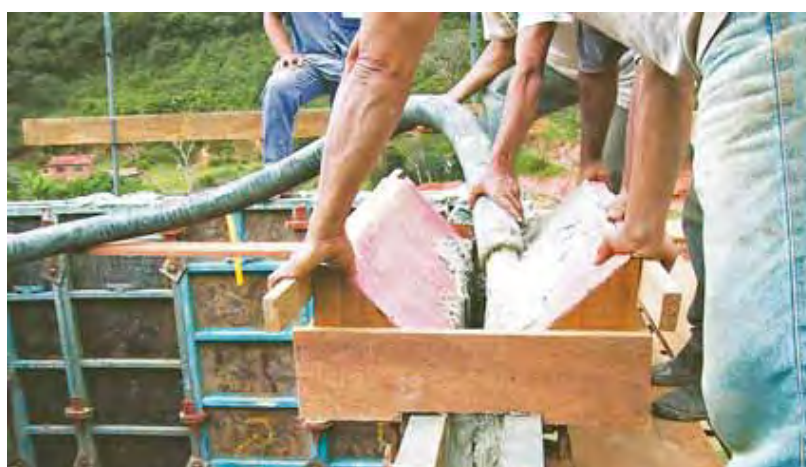
Figura 15 – Concretagem das paredes com uso de funil
