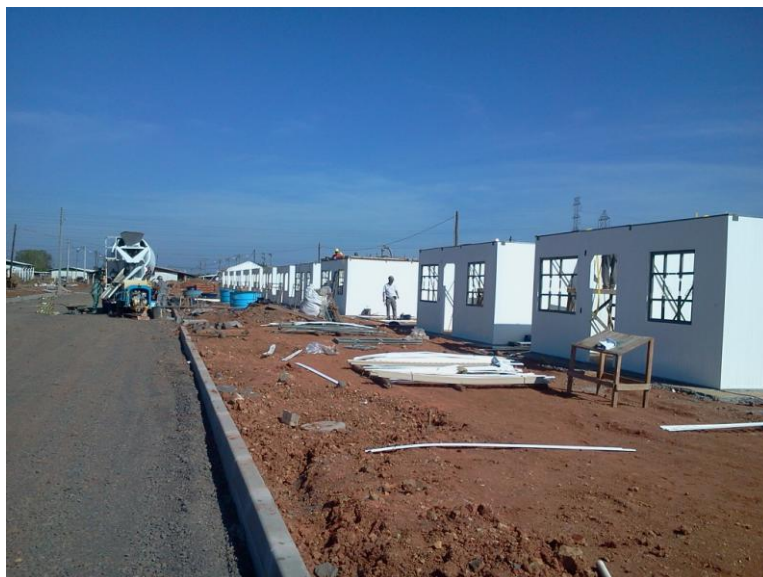
Figura 16 – Construção das habitações – Etapa de levantamento das paredes
