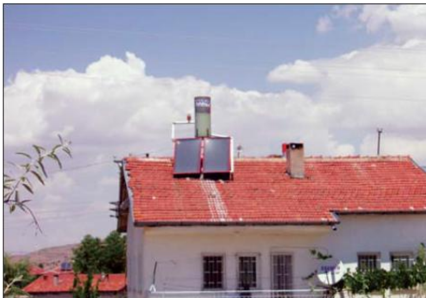
Figura 11 – Coletor apoiado em estrutura de suporte do coletor
