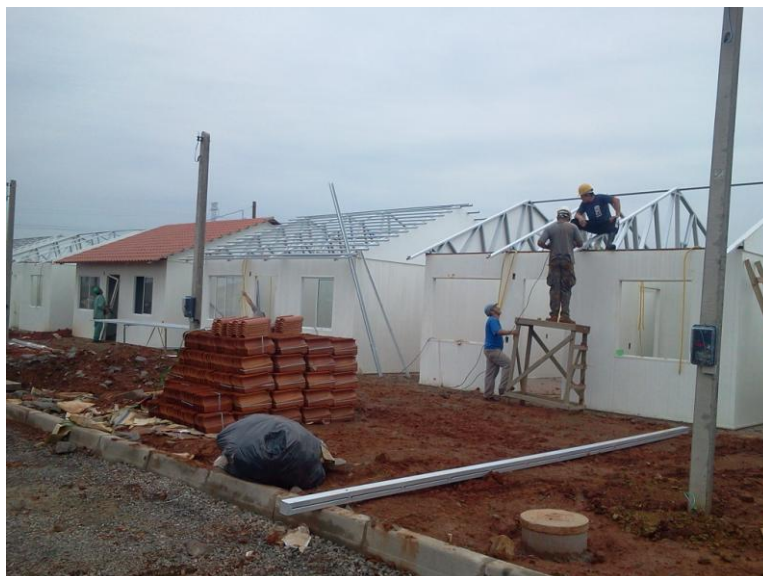
Figura 17 – Construção das habitações – Etapa de execução da cobertura
