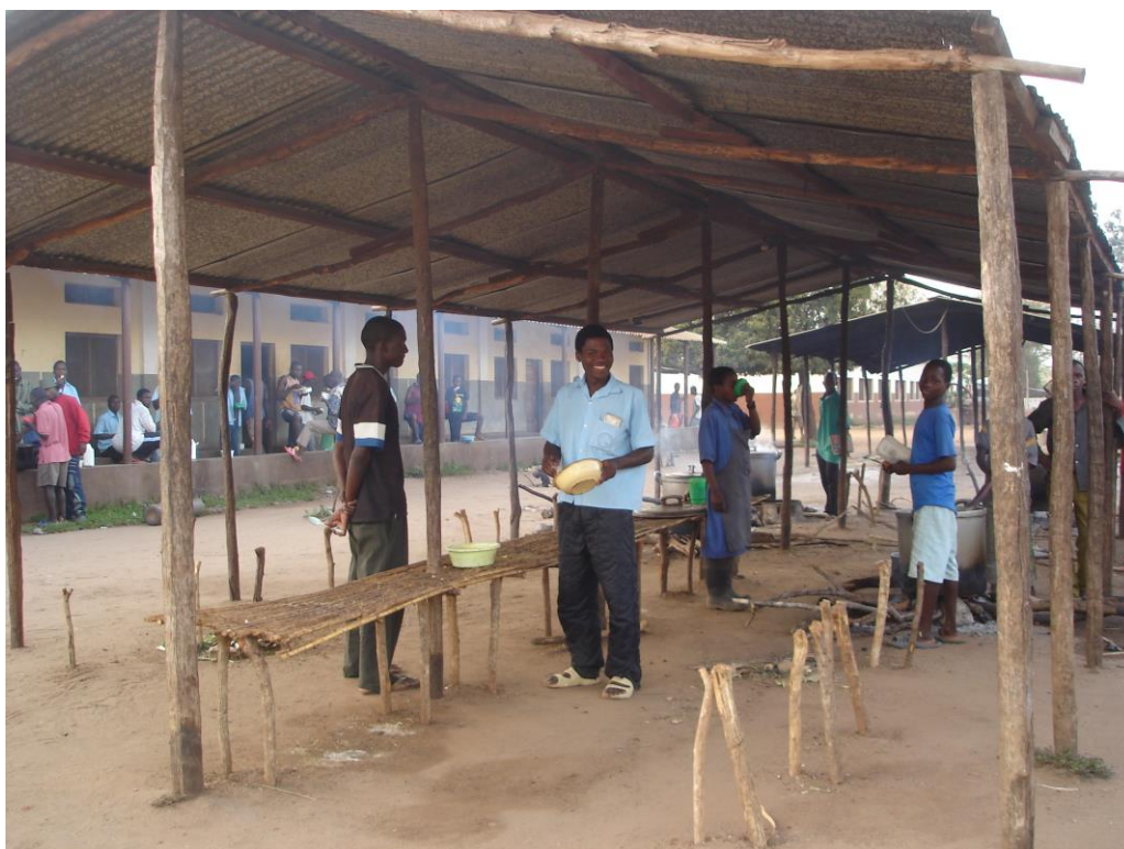
A “cozinha” do internato masculino, que funciona com panelas no chão
