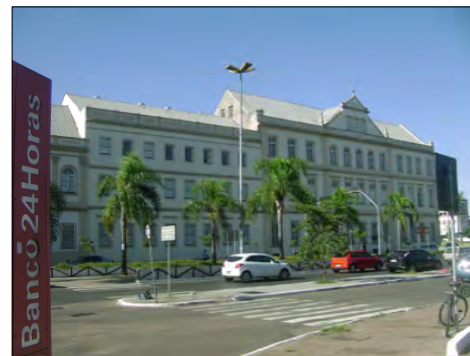
Vista do conjunto a ser preservado
