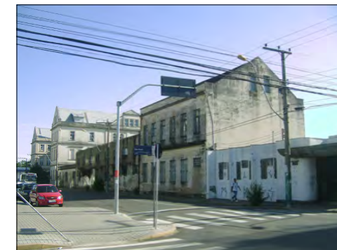
Vista das edificações a serem removidas
