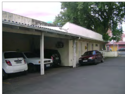
Vista da edícula a ser removida
