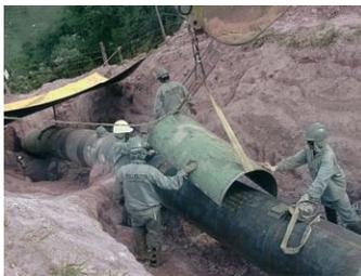
Figura 01 – Duto sendo reparado em operação.
