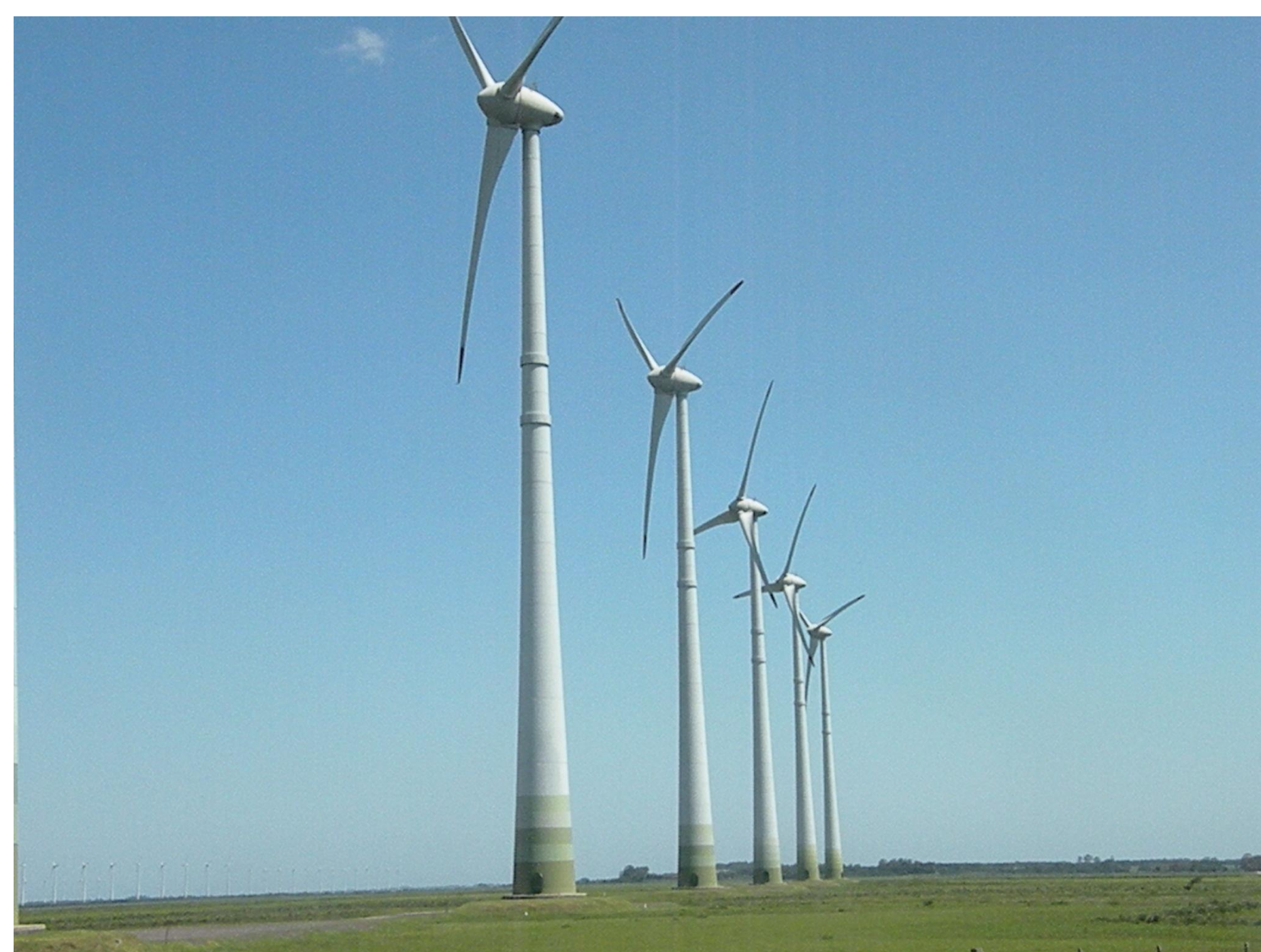
Imagem 1: Parque Eólico de Osório conta com investimentos de empresa espanhola e tecnologia alemã.
