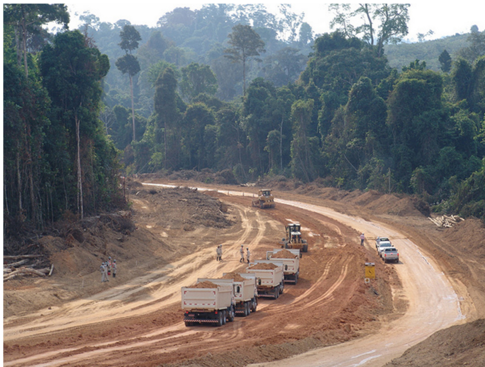
Figura 4: Canteiro de obras da usina hidrelétrica de Belo Monte. Fonte: Norte Energia.
