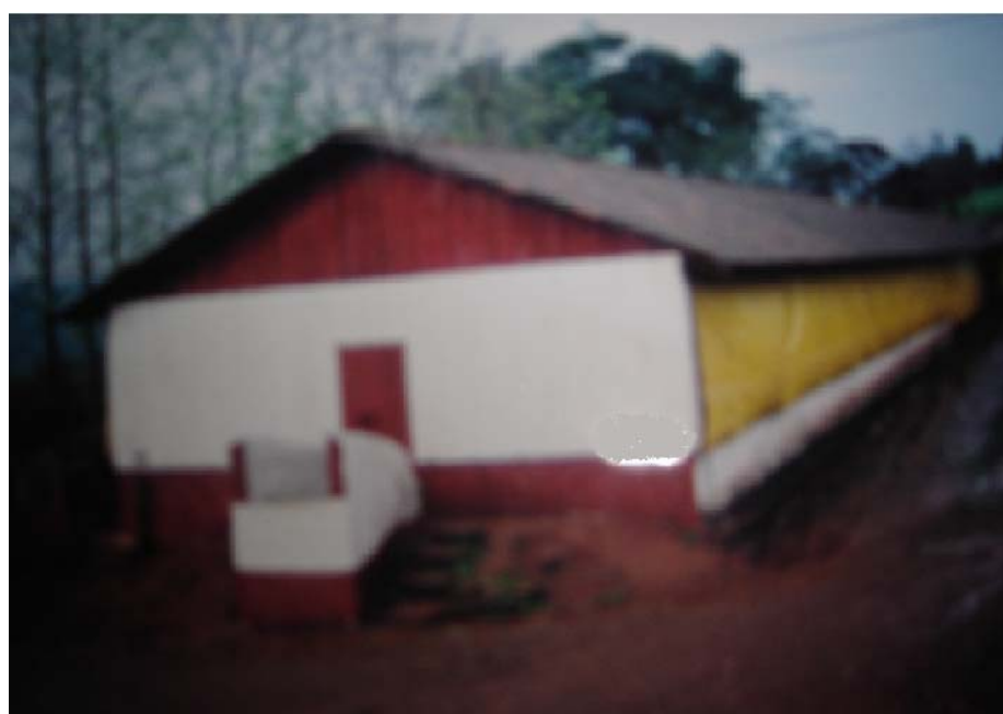
Figura 14: Chiqueiro reformado, pintado e protegido com lonas
