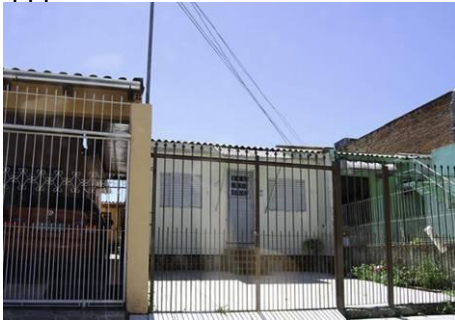
Figura 18: unidade das casas trigeminadas que mantém o aspecto original
