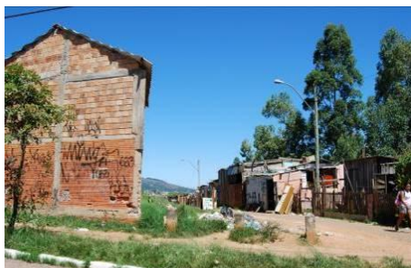
Figura 45: foto atual da ocupação irregular.
