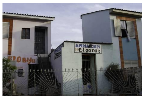
Figura 41: casas alteradas com atividade de armazém e loja de bijuterias .
