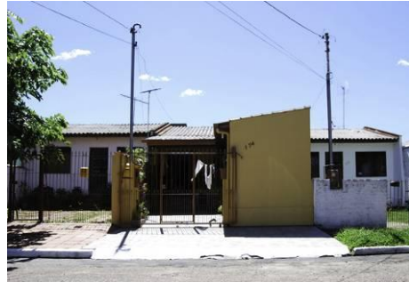
Figura 21: unidade das casas trigeminadas com ocupação do recuo.
