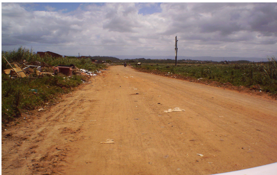
Figura 5: Via urbana sem arruamento definido com saibro (Maio/2005) – Foto do Autor
