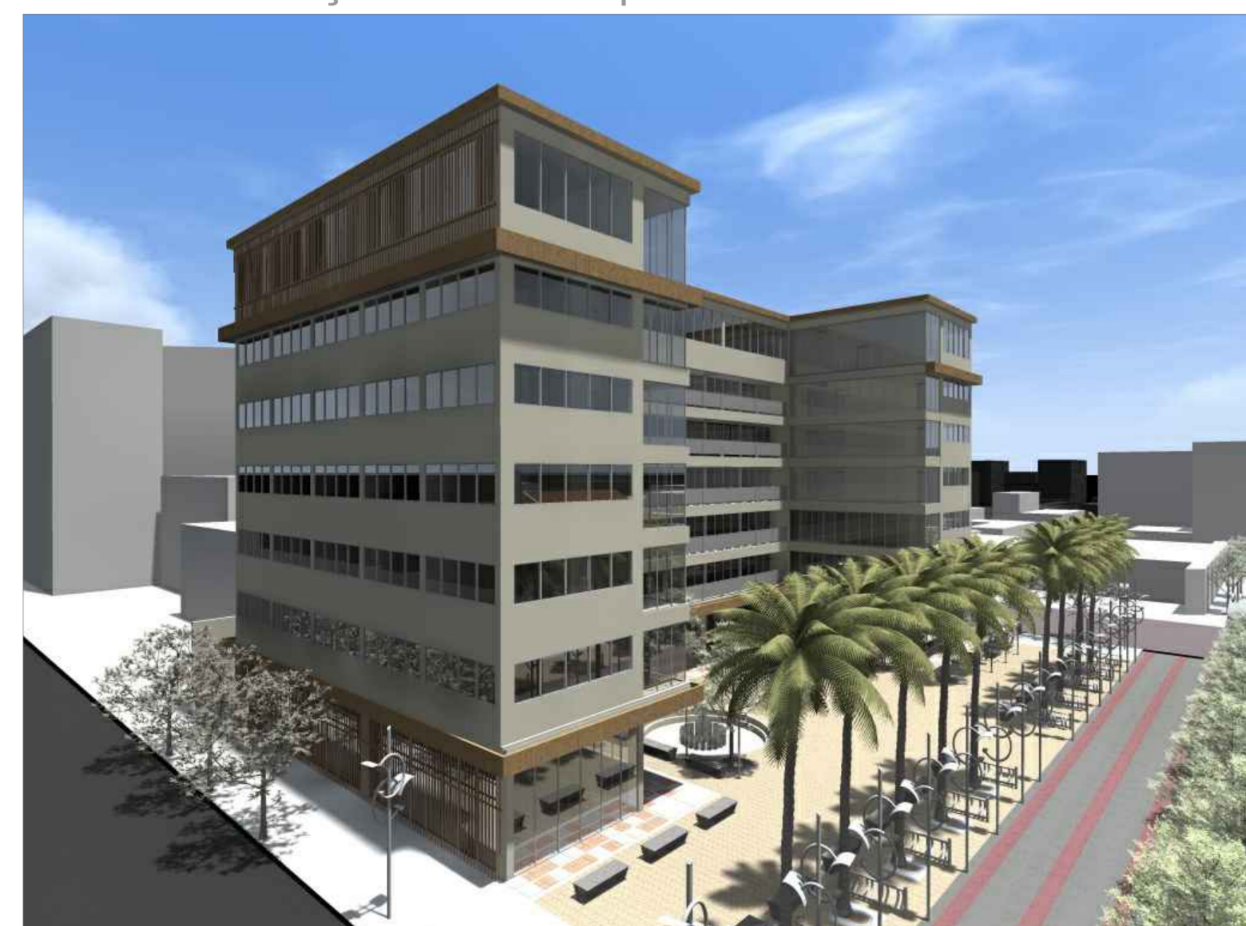
vista da habitação estudantil pela Rua Ernesto Alves
