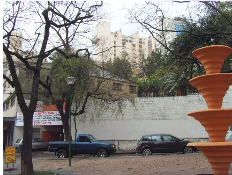
2 - fonte da praça e ao fundo as edificações a serem demolidas
