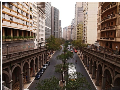
Viaduto Otávio Rocha
