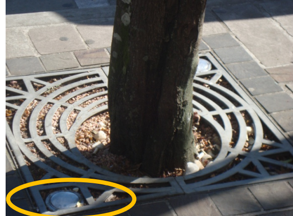
Figura 44 – Detalhe da iluminação junto às árvores
