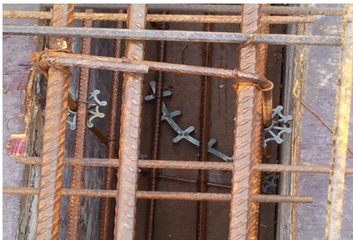
Figura 44 – Espaçadores utilizados nas vigas das obras visitadas
