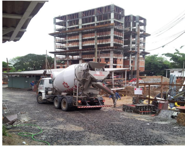
Figura 28 – Canteiro das obras B1 e B2
