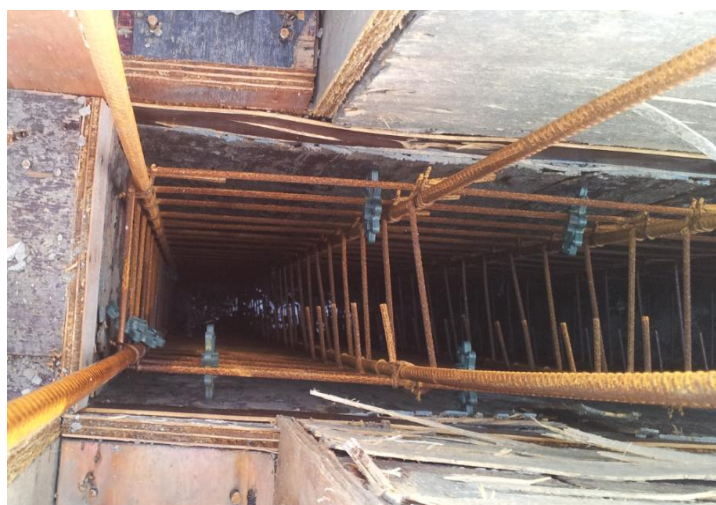
Figura 45 – Espaçador utilizado nos pilares das obras visitadas
