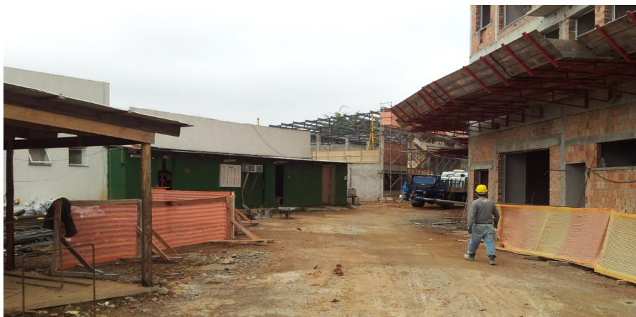
Figura 30 – Canteiro da obra C
