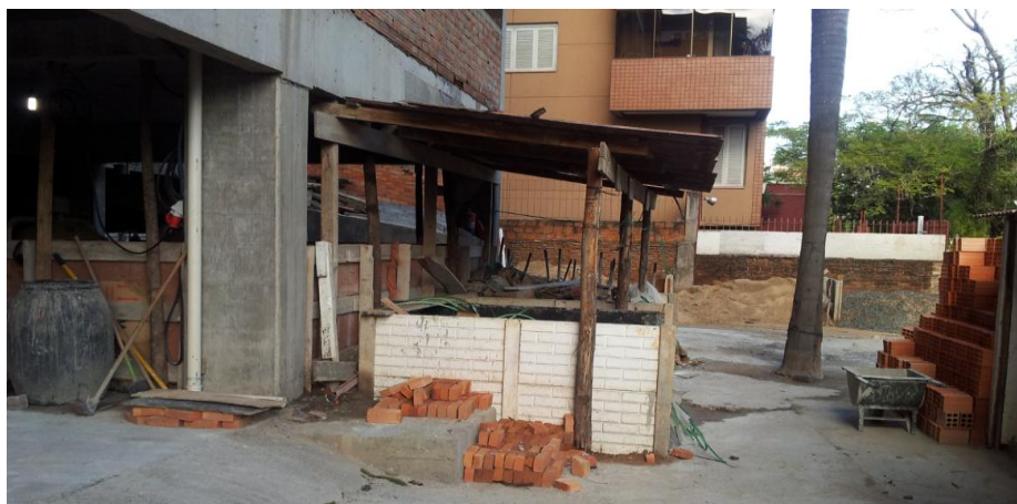
Figura 31 – Canteiro da obra D
