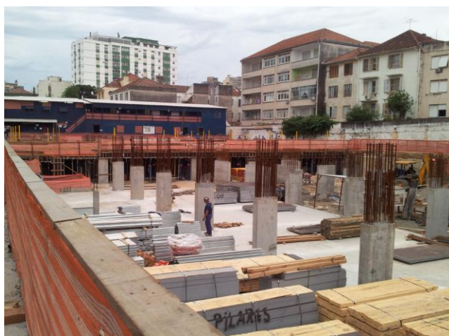
Figura 27 – Canteiro da obra A
