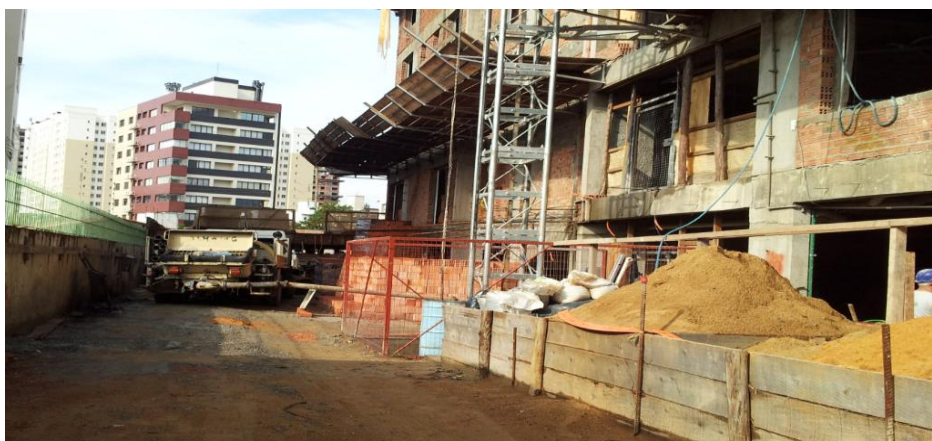
Figura 32 – Canteiro da obra E
