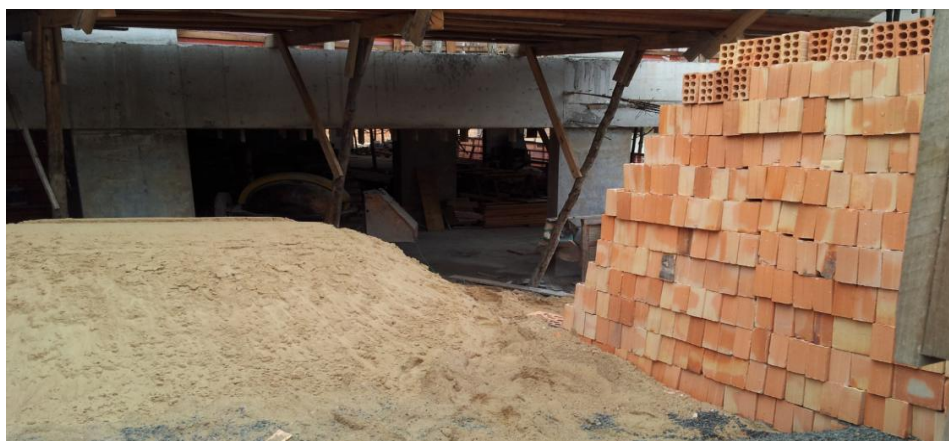
Figura 33 – Canteiro da obra F
