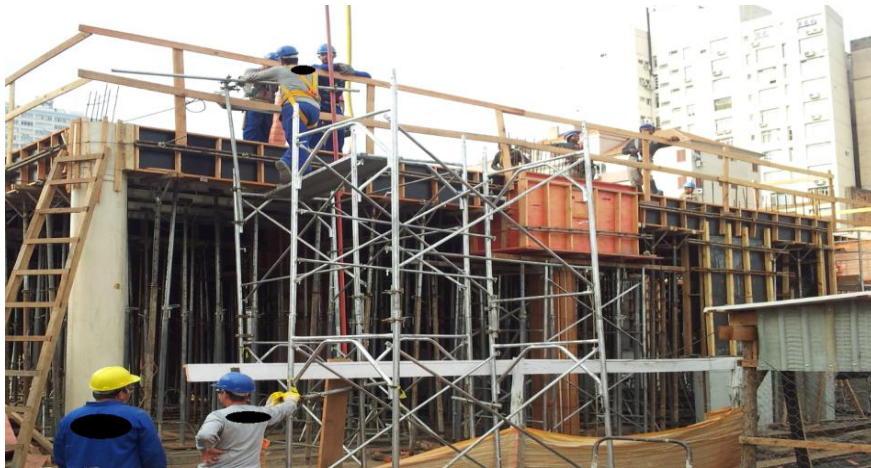
Figura 34 – Canteiro da obra G
