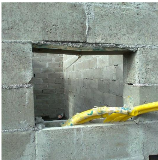
Figura 12 – quadro de distribuição adaptado à modulação da alvenaria
