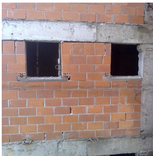
Figura 20 – blocos compensadores acima das contravergas
