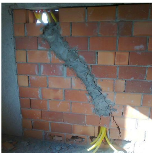
Figura 25 – inserção dos eletrodutos com cortes nos blocos
