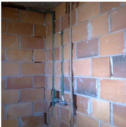
Figura 10 – inserção das instalações do chuveiro
