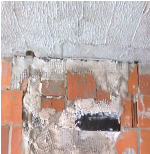
Figura 18 – (a) material de descarte usado para a vedação; (b) cortes junto à janela da cozinha
