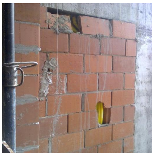
Figura 15 – faces dos blocos que se destacavam das paredes
