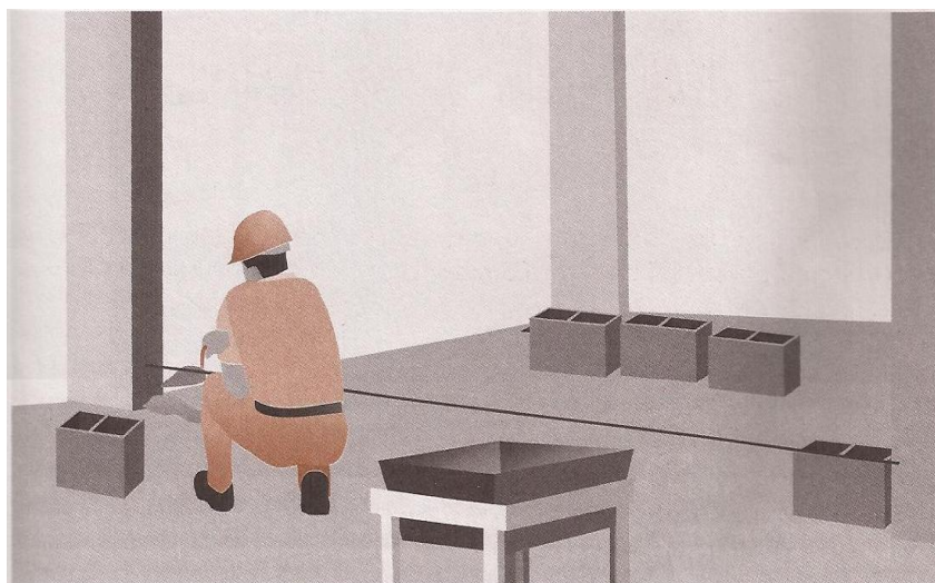
Figura 5 – Execução da locação da alvenaria
