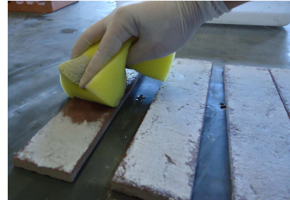
Figura 22 – Limpeza da superfície da placa cerâmica
