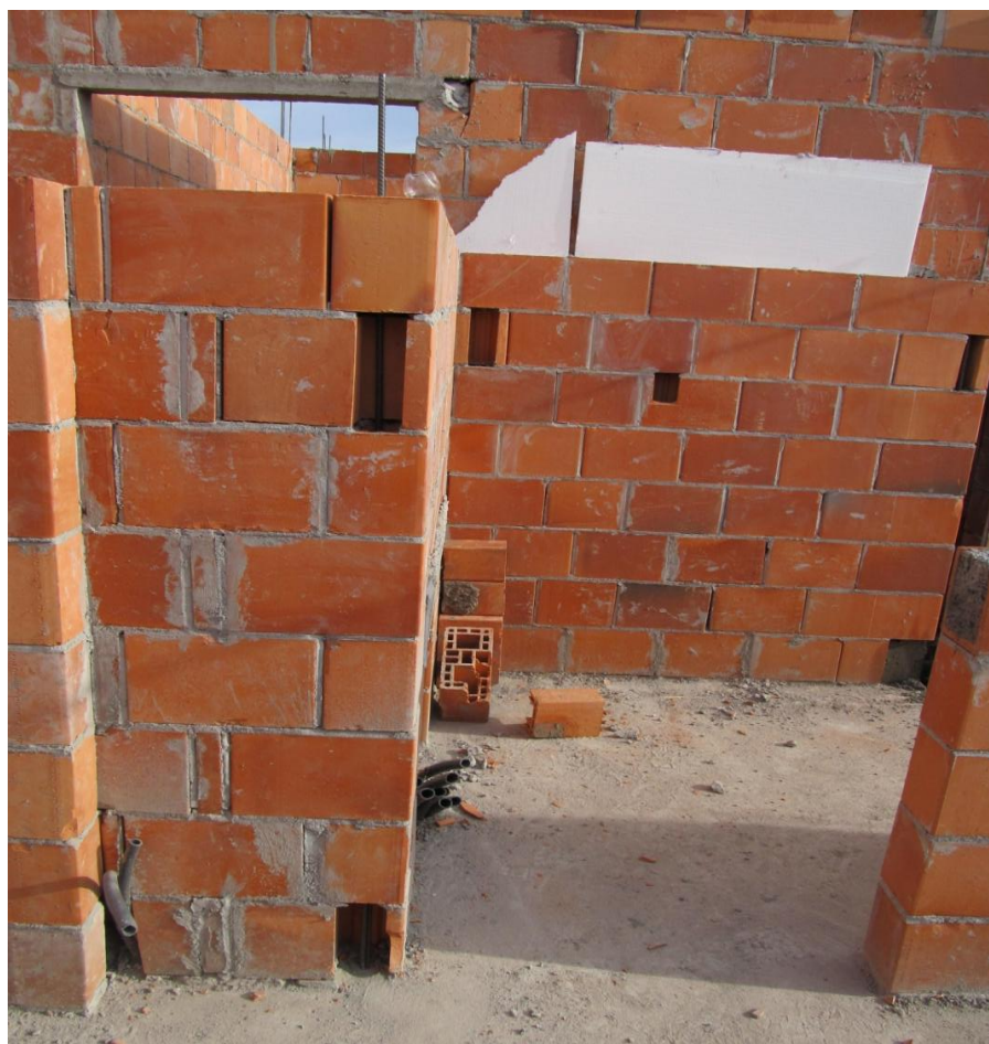
Figura 7 – Janelas de inspeção e corte com máquina
