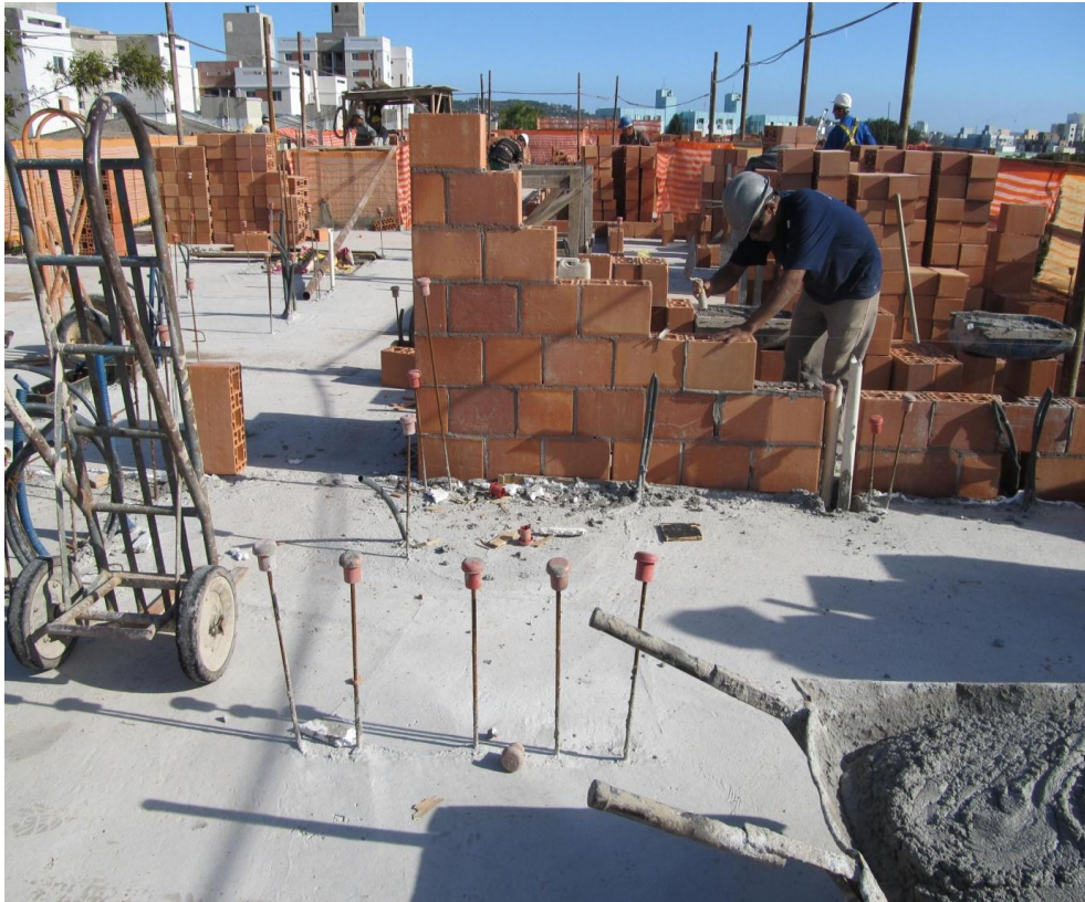
Figura 9 – Construção correta do castelinho nas amarrações de contrafiadas
