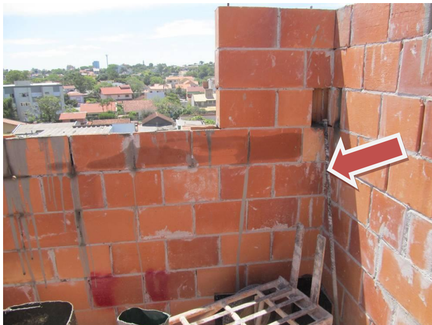
Figura 20 – Utilização de haste metálica para adensamento de graute vertical
