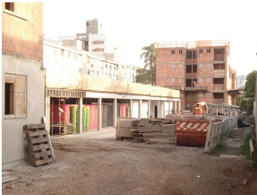
Figura 6 – Obra acompanhada durante a execução do sexto pavimento
