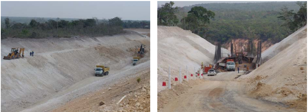
Figura 29 – PCH Sacre 2: canal de adução
