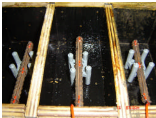
Figura 16: Vista das formas prismáticas, com as barras posicionadas nos espaçadores
