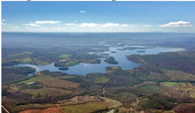
Figura 4 - Vista aérea da Barragem do rio Salinas.
