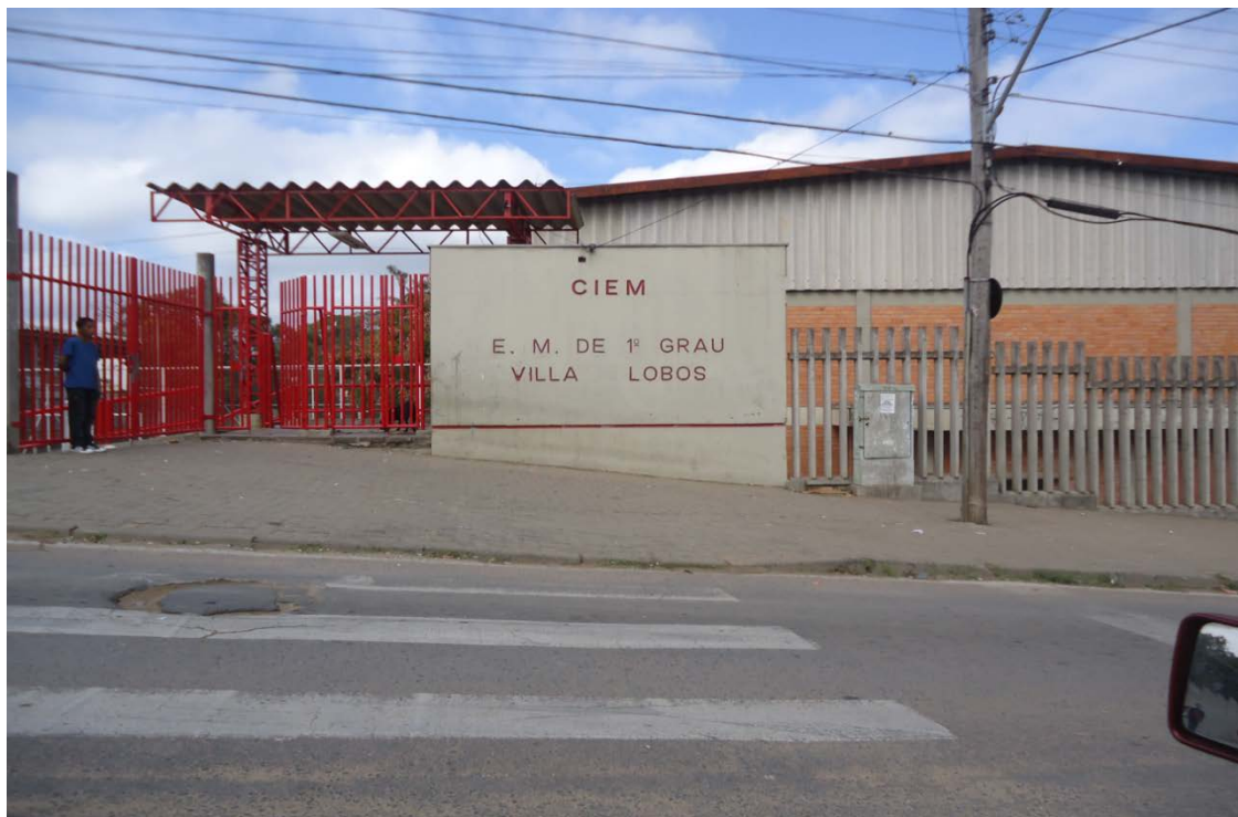
Figura 2 — Escola Municipal Villa-Lobos
