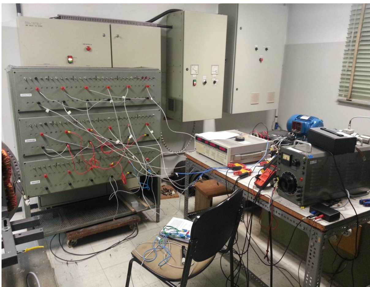
Figura 51 – Montagem do quadro de cargas
