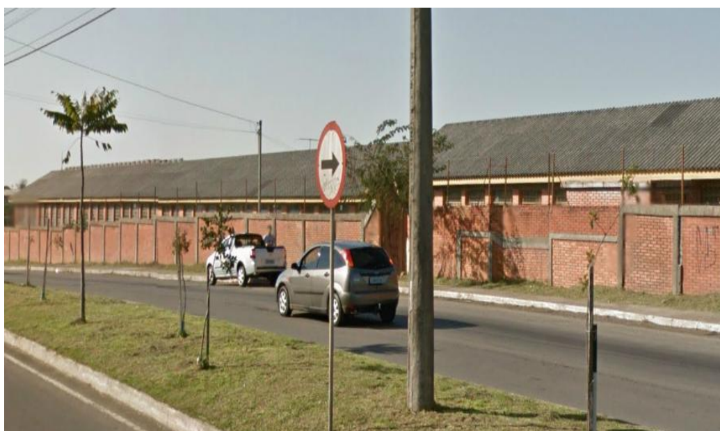
Figura 11 – Vista da rua da escola Olga Maria Kayser
