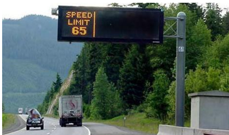
Figura 17 – Painel para harmonização de velocidades nos Estados Unidos
