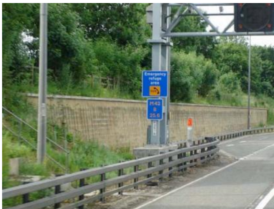
Figura 6 – Refúgio de emergência equipado com telefone na Inglaterra
