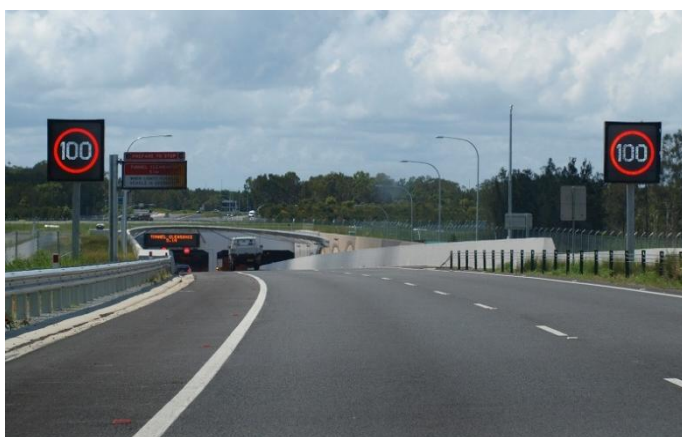
Figura 16 – Harmonização de velocidades na Rodovia M1, na Austrália
