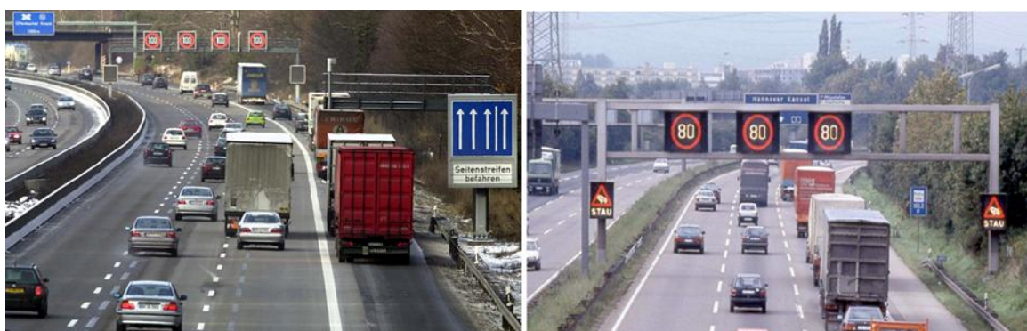
Figura 18 – Rodovia Alemã com harmonização de velocidades
