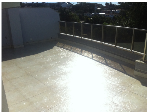
Figura 7 – Terraço da Edificação B
