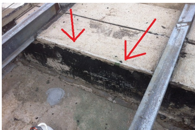
Figura 6 – Reboco descolado causando o aparecimento da impermeabilização
