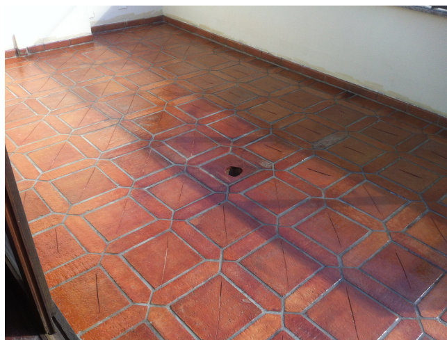
Figura 8 – Terraço da Edificação C
