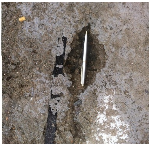
Figura 10 – Falha a ser regularizada na laje de cobertura da Edificação A
