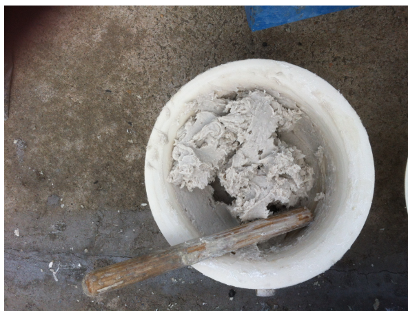
Figura 38 – Selante utilizado para vedar corte
