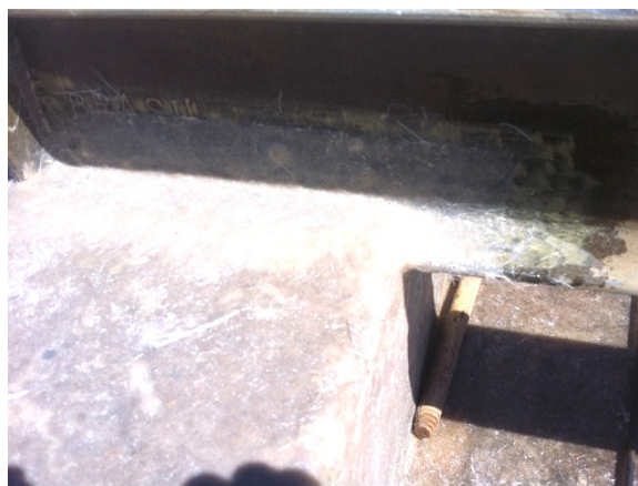
Figura 23 – Detalhe de estrutura metálica impermeabilizada
