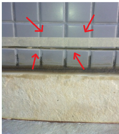
Figura 24 – Detalhes de corte no rejunte e fita de nivelamento
