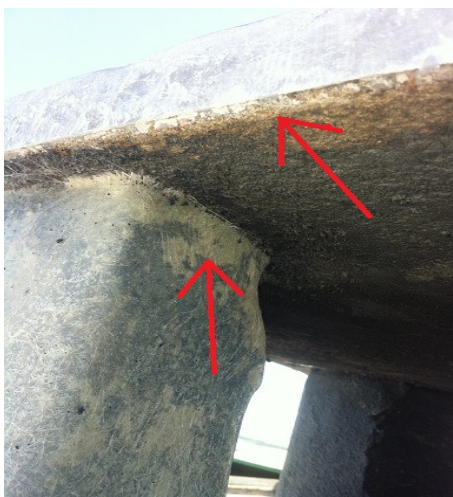
Figura 31 – Descontinuidade do sistema em face inferior de estrutura
