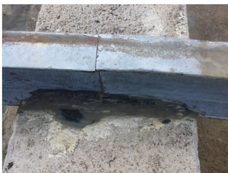
Figura 22 – Aplicação de resina como selante impermeável
