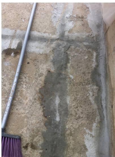
Figura 14 – Regularização com pasta de cimento no entorno da platibanda
