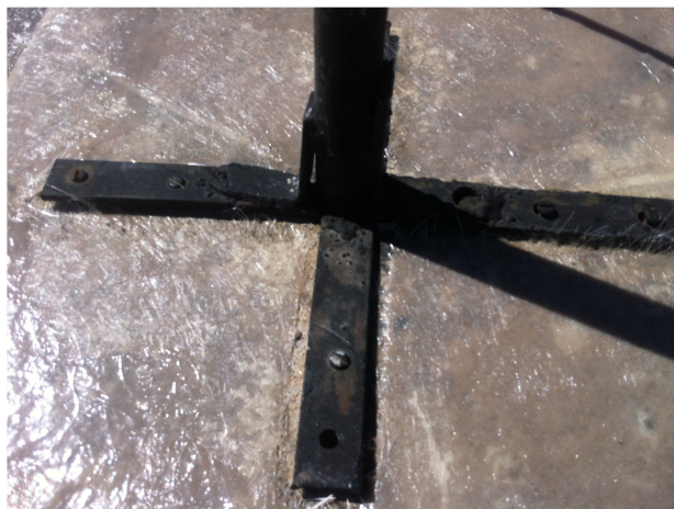
Figura 12 – Detalhe de impermeabilização no entorno de antena ainda não selada
