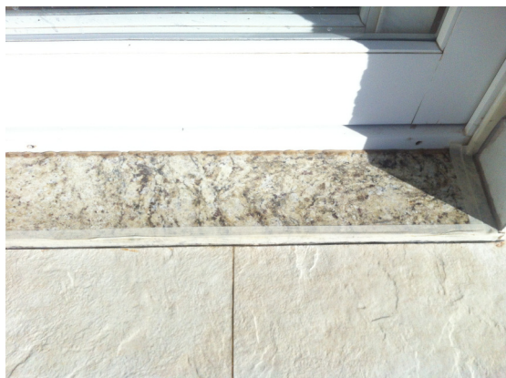
Figura 37 – Corte abaixo de soleira para ancoragem do véu de fibra
