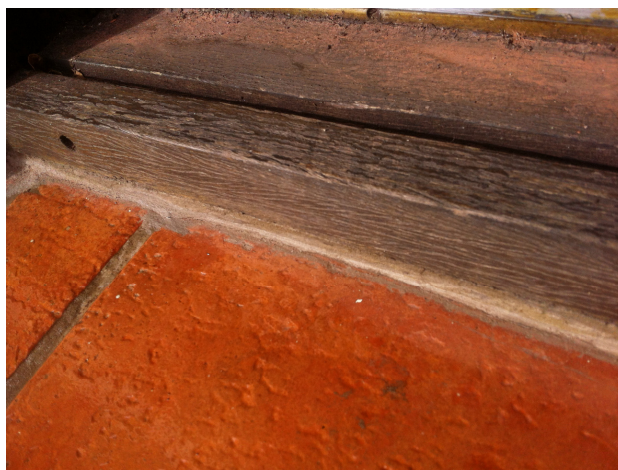
Figura 34 – Desnível pequeno de soleira para embutimento sob a mesma
