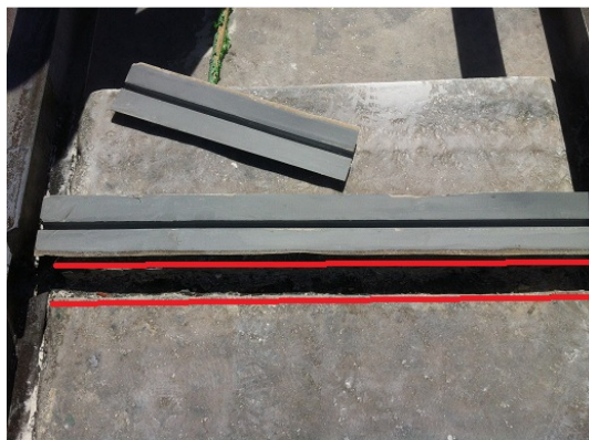
Figura 41 – Junta de dilatação a ser impermeabilizada
