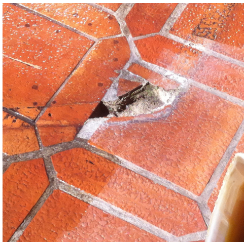
Figura 11 – Vazio a ser regularizado na superfície da Edificação C
