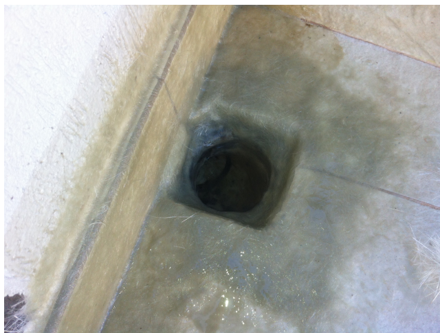
Figura 19 – Detalhe de ralo impermeabilizado
