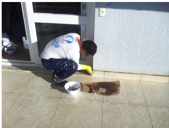
Figura 13 - Lixamento de canto vivo antes de aplicar o sistema
