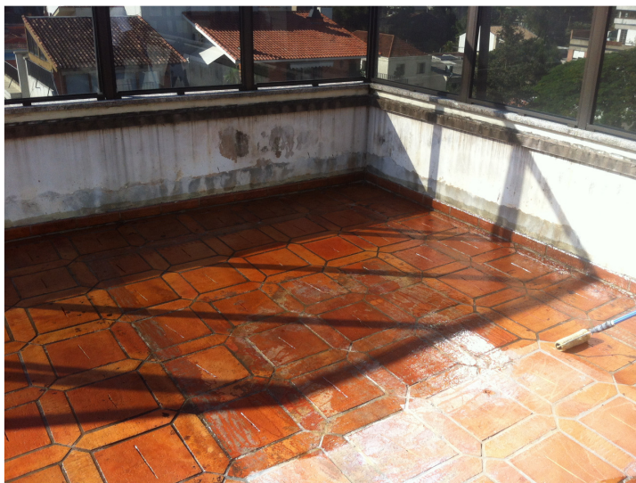
Figura 17 – Aplicação de primer na Edificação C
