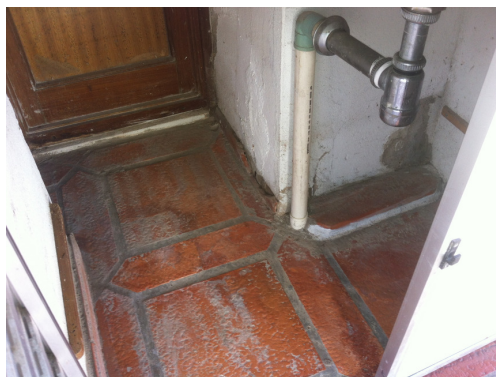
Figura 26 – Interior de balcão de pia com rodapé a ser impermeabilizado
