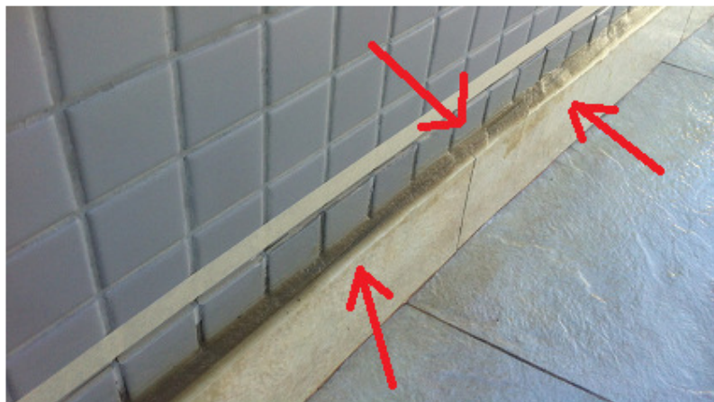
Figura 15 – Pasta de resina aplicada no topo do rodapé para regularização
