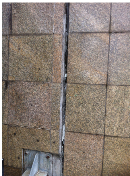
Figura 40 – Junta de dilatação com material de vedação desgastado
