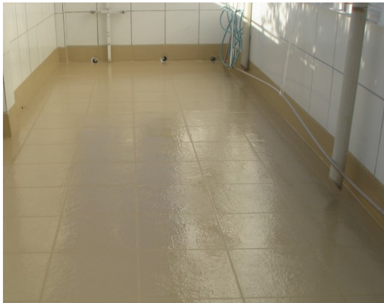
Figura 2 – Detalhe de impermeabilização de rodapé
