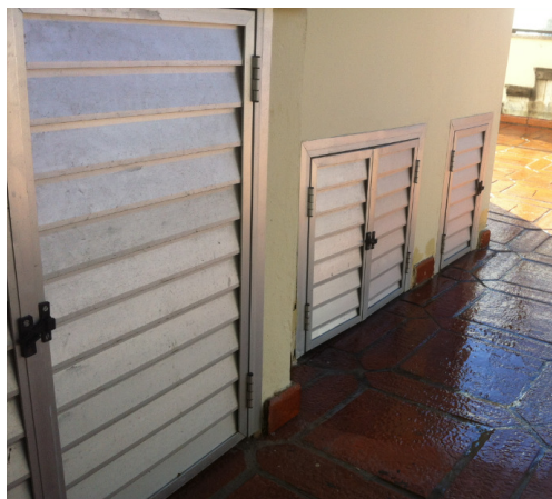
Figura 25 – Portas sem soleira interrompendo a continuidade do rodapé
