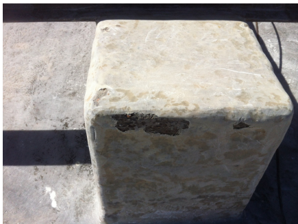
Figura 30 – Falha na impermeabilização em mudança de plano
