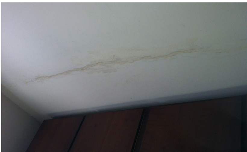
Figura 9 – Manifestação patológica ocasionada por infiltração
