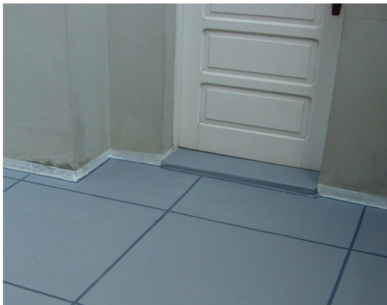
Figura 3 – Detalhe de impermeabilização sobre soleira e rodapé
