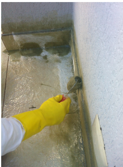
Figura 27 – Aplicação do sistema em rodapé de canto
