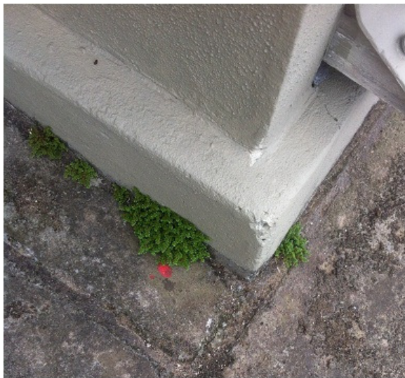
Figura 5 – Crescimento de vegetação decorrente da presença de umidade
