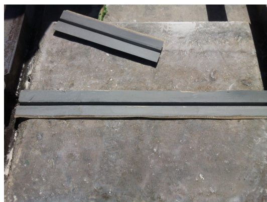
Figura 42 – Detalhe do posicionamento de mata-junta
