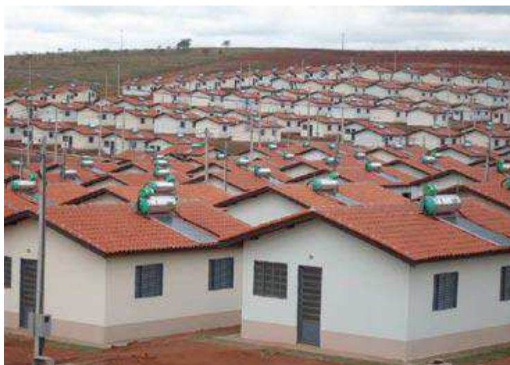
Figura 6 – Coletores solares em residências do Programa Minha Casa Minha Vida
