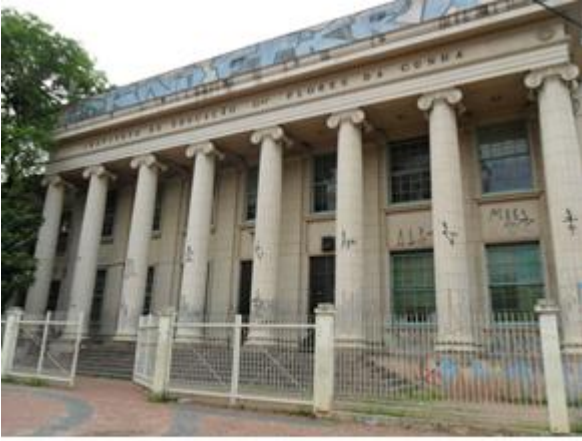
Foto da fachada do colégio.
