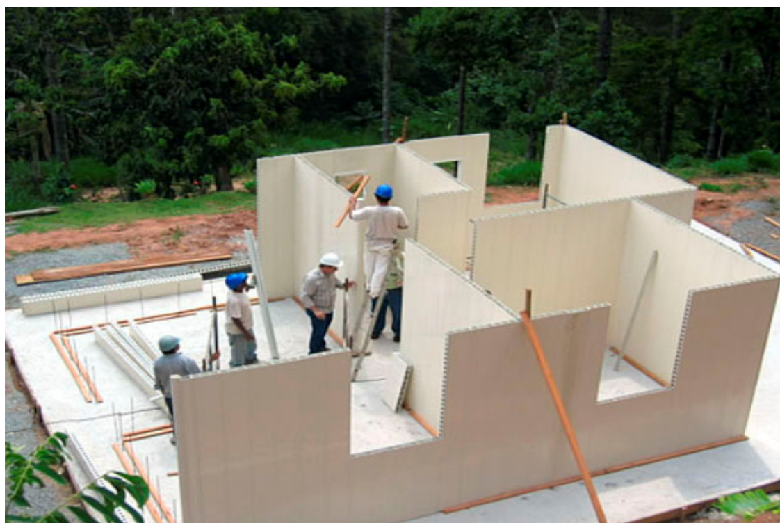
Figura 3 - Protótipo de casa construída em Sistema Concreto – PVC
