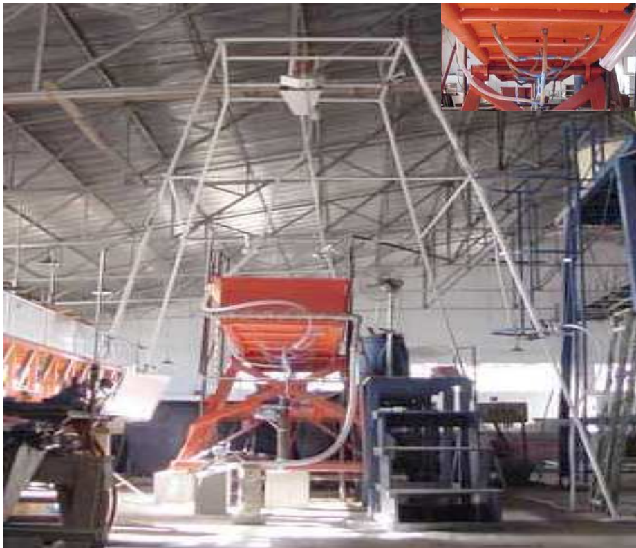
Figura 4.3. – Vista geral do canal de declividade variável, da posição do simulador de chuva, das demais instalações experimentais e detalhe da forma de fixação e conexão das mangueiras no fundo do canal.
