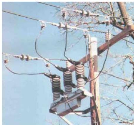
Figura 5: Seccionador automático instalado (JOSLYN HIGH VOLTAGE, 1996).
