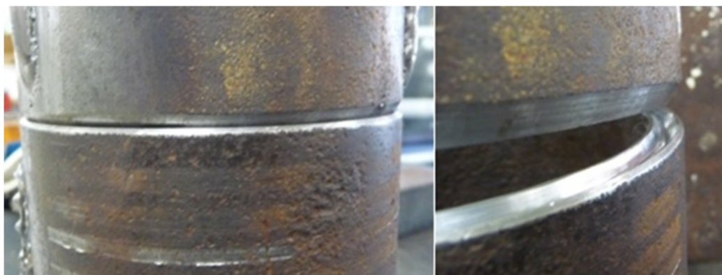
Figura 4.78 – Usinagem dos tubos para soldagem tubo com tubo.
