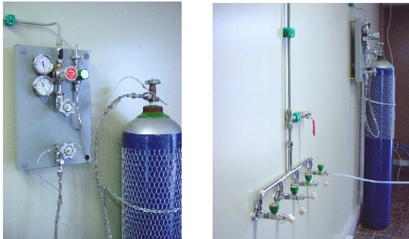
Figura 3-12: Fotografias do sistema para abastecimento de gases do LAMEF.
