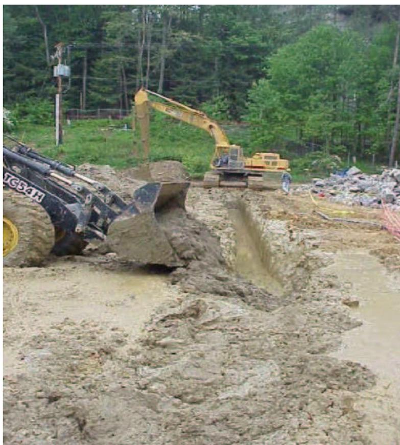
Figura 2.2 – Lançamento da mistura de Solo-Cimento-Bentonita para dentro da trincheira (Fonte: Ryan e Day, 2002).
