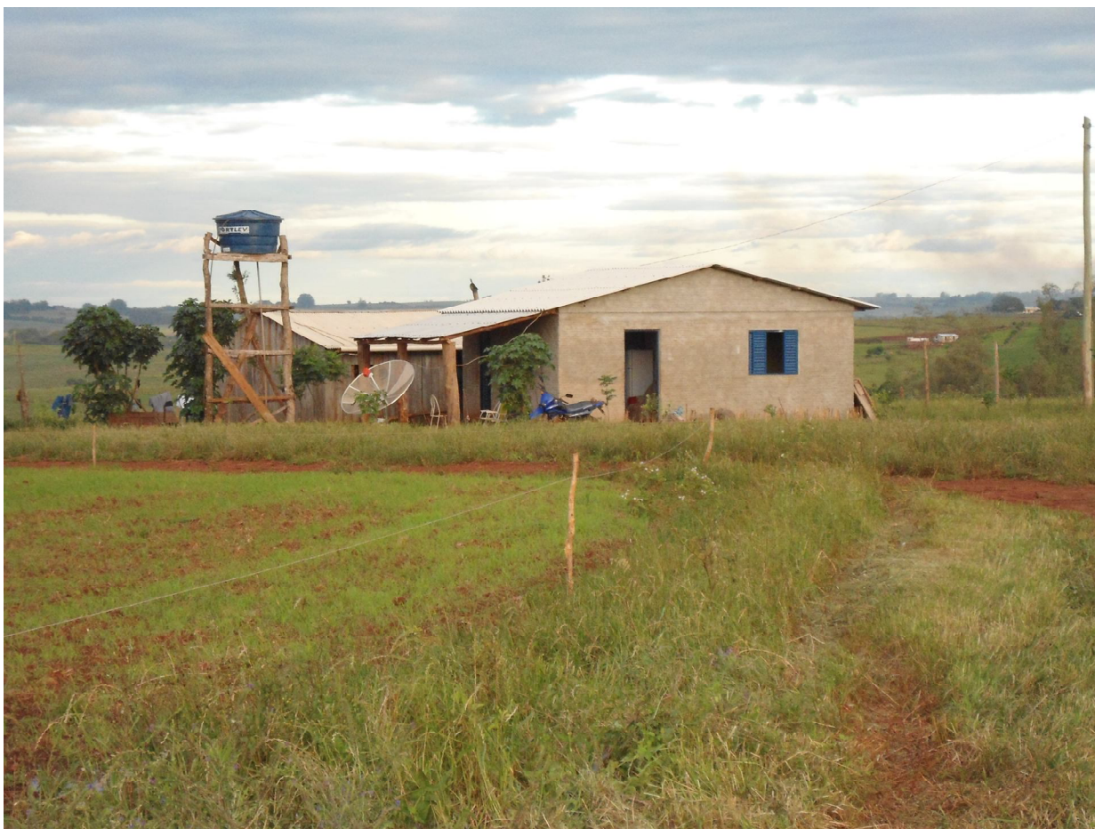
Figura 10 – Casa de moradia e galpão de um beneficiário.
