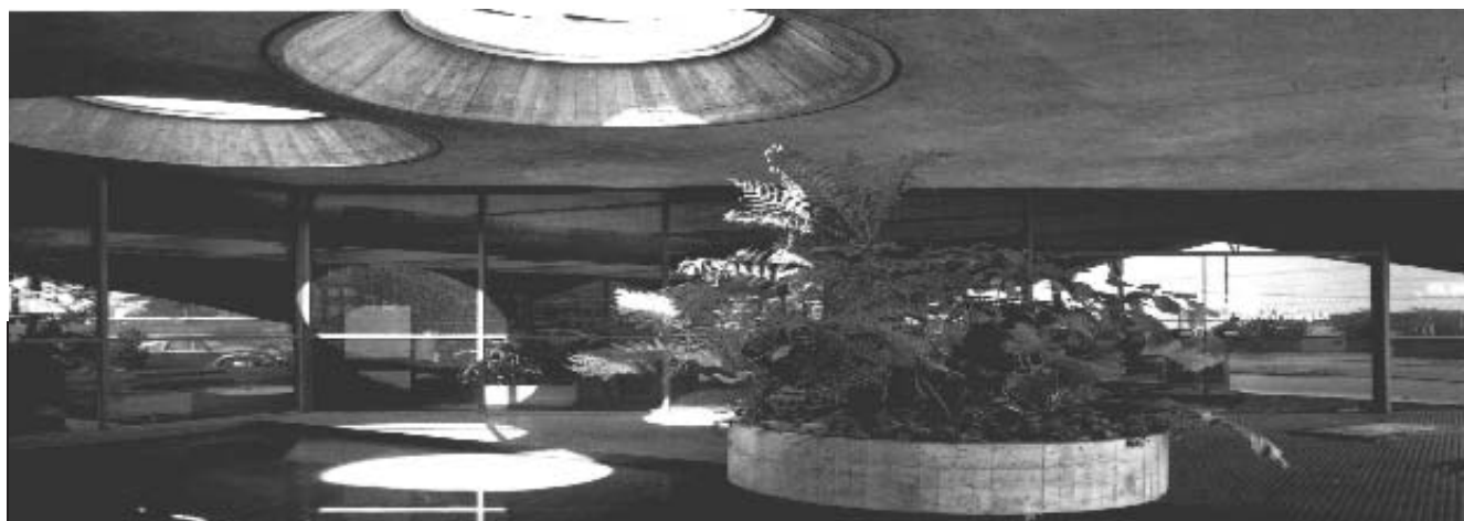
FIGURA 4.8 DETALHE ILUMINAÇÃO ZENITAL
