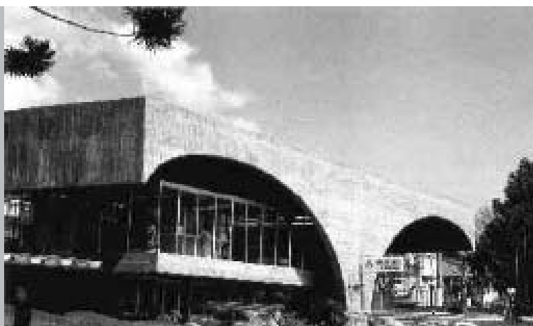
FIGURA 4.1 CENTRAL TELEFÔNICA DA TELESP, CAMPOS DO JORDÃO, 1973 VISTA DA AVENIDA PRINCIPAL
