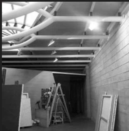
FIGURA 3.22 ABERTURA ZENITAL NO ATELIER NOVO
