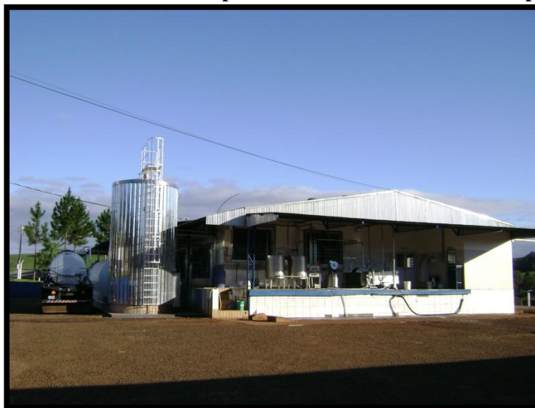
Figura 33 - Laticínios com capacidade instalada de 40 mil litros por dia
