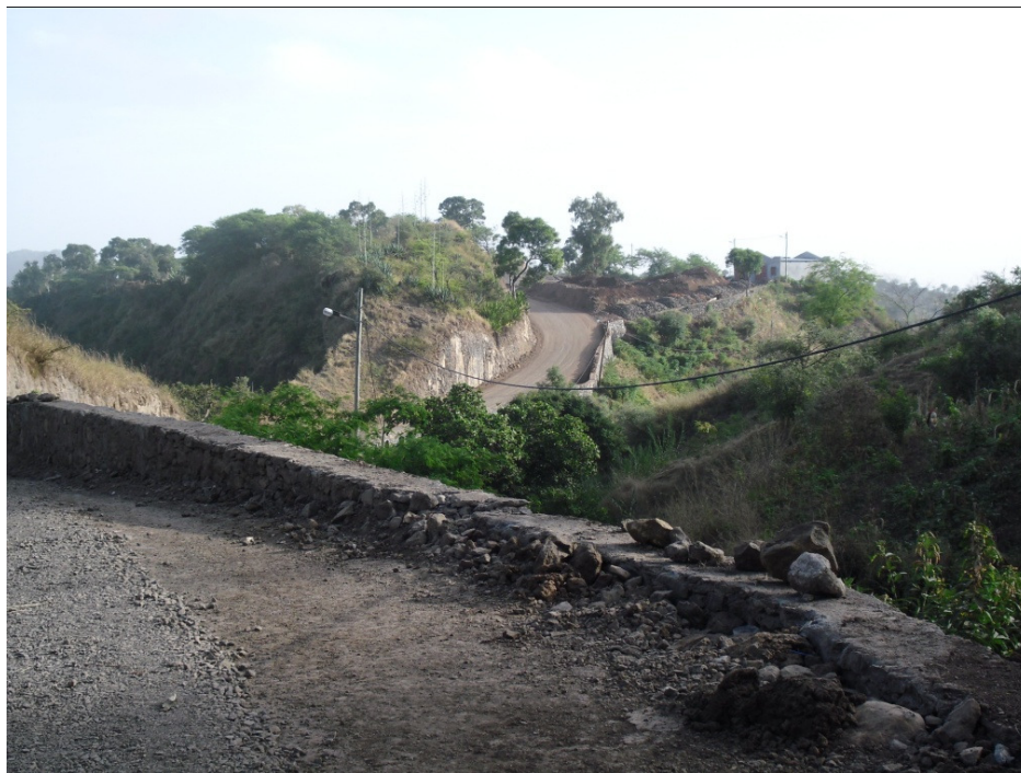
Figura 1 - Estrada Achada Leitão
