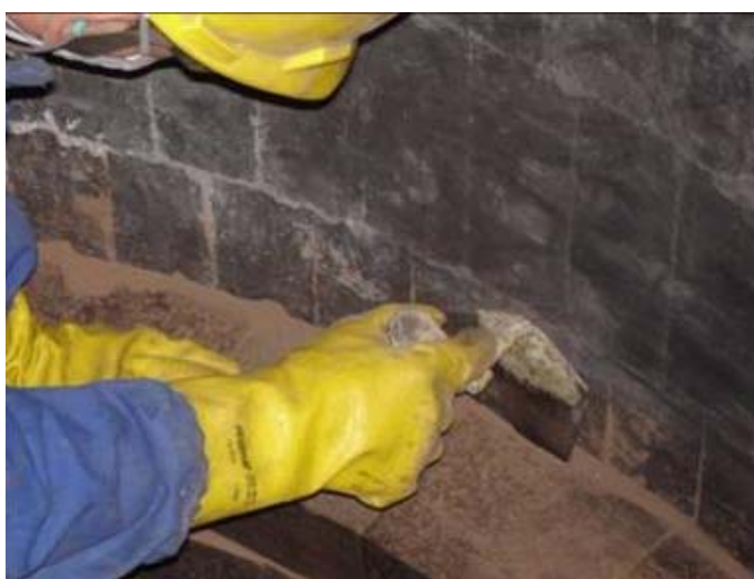
Figura 3.5 – Montagem dos Refratários de Trabalho Parede da Panela Fonte Gerdau Riograndense, 2009.
