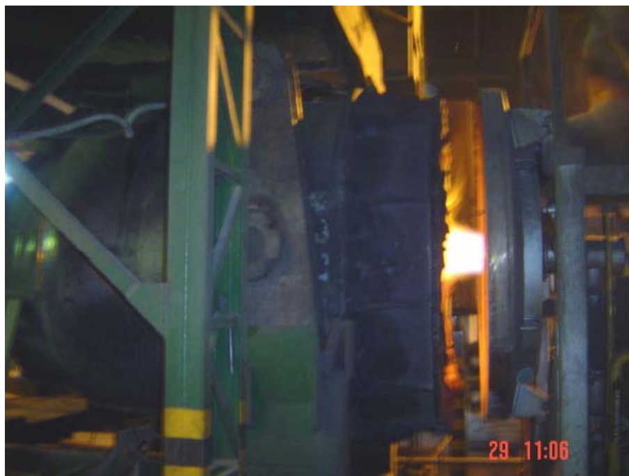
Figura 3.13 – Panela no Trole de Aquecimento Fonte Gerdau Riograndense, 2009.
