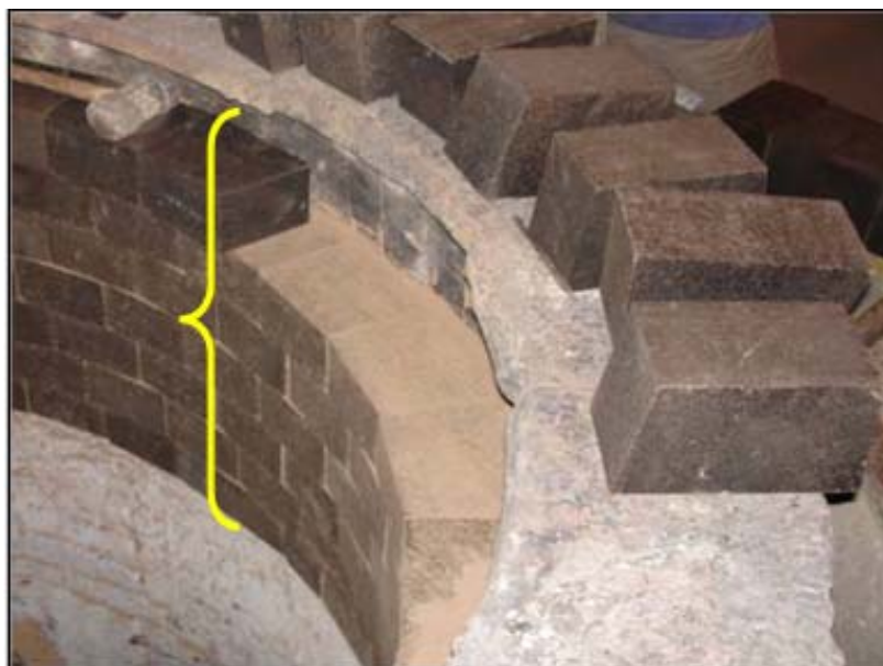
Figura 3.6 – Montagem da Linha de Escória da Panela
