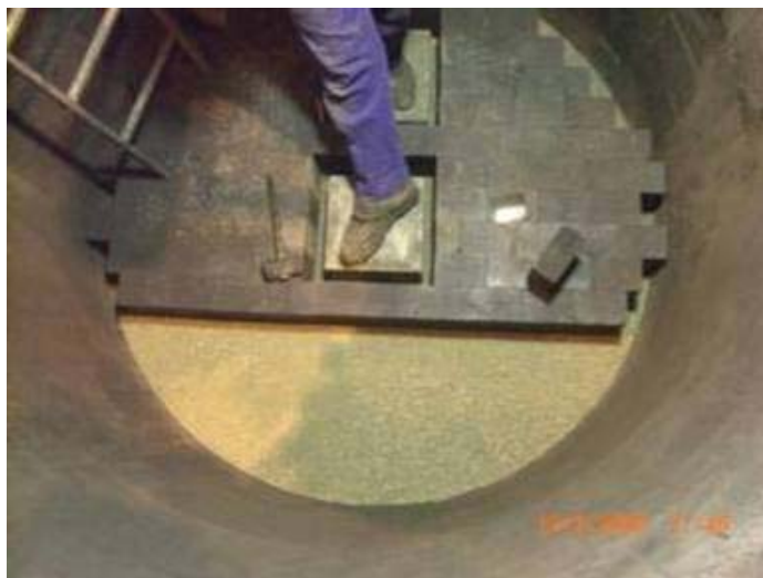
Figura 3.4 – Montagem dos Refratários de Trabalho Fundo da Panela Fonte Gerdau Riograndense, 2009.
