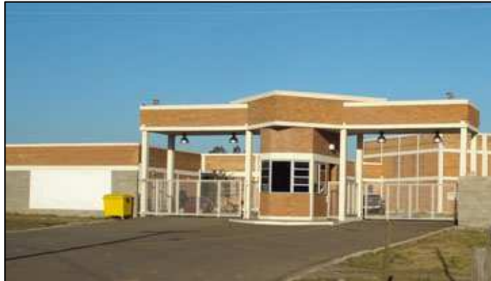
Sede do Instituto Federal Sul-rio-grandense, Campus Charqueadas. Créditos da imagem: divulgação site IFSul.
