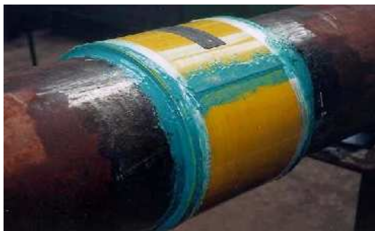
Figura 2.29. Crack arrestor instalado em trecho de duto. (RACE 2006)
