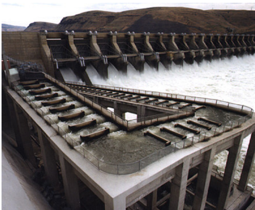
Figura 3.8. Escada do tipo piscina vertedouro da Barragem de John Day, no rio Columbia.
