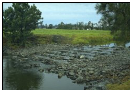
Figura 3.19. Escada de peixes do tipo Canal Natural em Bandon Grove, no Rio Williams, Austrália.
