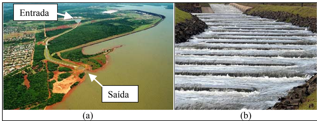
Figura 3.18. Escada de peixes do tipo Canal Natural da Barragem de Itaipu, formada por obstruções a espaçamentos sucessivos: (a) vista aérea e (b) detalhe do canal.
