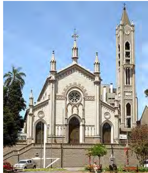
Fachada da Catedral de Caxias do Sul, concluída em 1889
