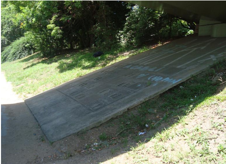
Figura 6 – Passarela dos Campeões.
