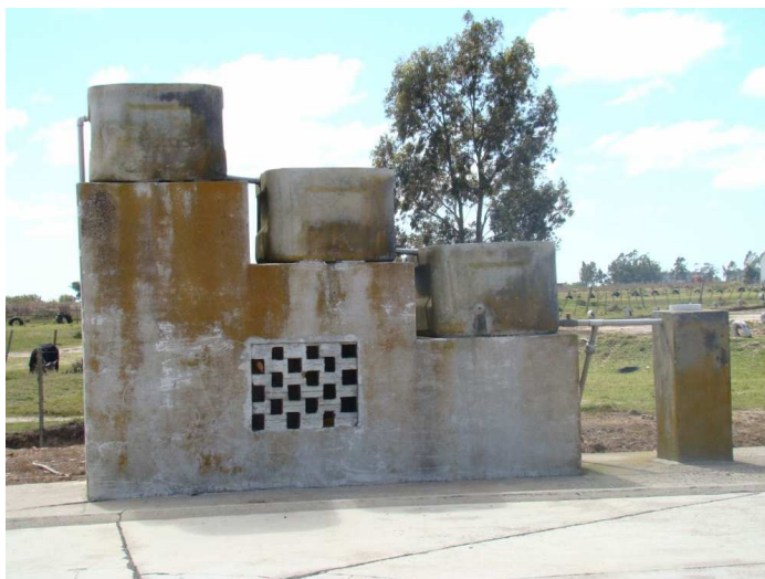
FIGURA 3 – Sistema de caixas com calcário com o pressuposto de filtrar e reagir com o efluente para elevação do pH, em Aviação Agrícola, no município de Santa Vitória do Palmar (RS). Porto Alegre, 2012.
