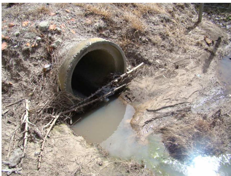
FIGURA 4 – Descarte do efluente após a passagem pelas caixas com calcário. Lançamento direto no córrego que deságua no local de captação de água do município de Santa Vitória do Palmar. Vegetação morta ao seu entorno, no ano de 2009. Porto Alegre, 2012.
