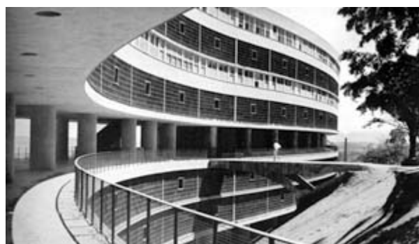
FIGURA 28 – Vista parcial do Bloco A do Conjunto Residencial do Pedregulho, projeto do arquiteto Affonso Eduardo Reidy 1952. Acervo Carmem Portinho. Fonte: Affonso Eduardo Reidy (2000). Coleção arquitetos brasileiros. Instituto Bardi / Blau, São Paulo
